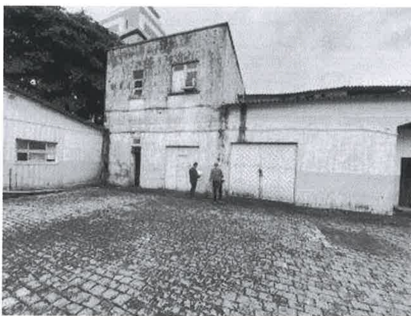
Vista interna do imóvel avaliando
