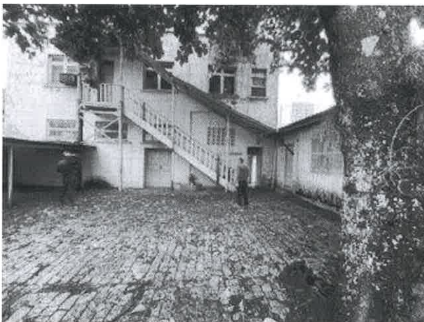
Vista interna do imóvel avaliando
