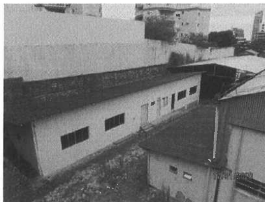
Figura 38 – Vista superior (coberturas).
