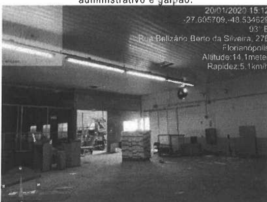
Figura 23 – Vista interna do galpão.
