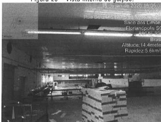
Figura 30 – Vista interna do galpão.
