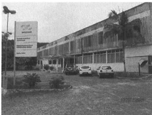
Figura 01 – Vista frontal do imóvel avaliando.
