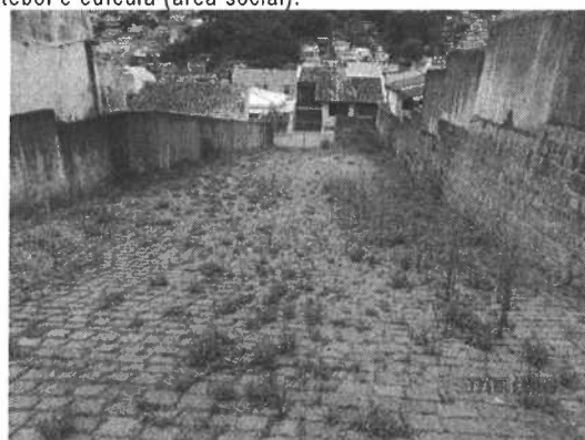
Figura 52 – Acesso lateral – imóvel da matrícula nº 140.
