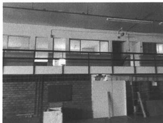
Figura 26 – Vista interna do galpão – parte administrativa.
