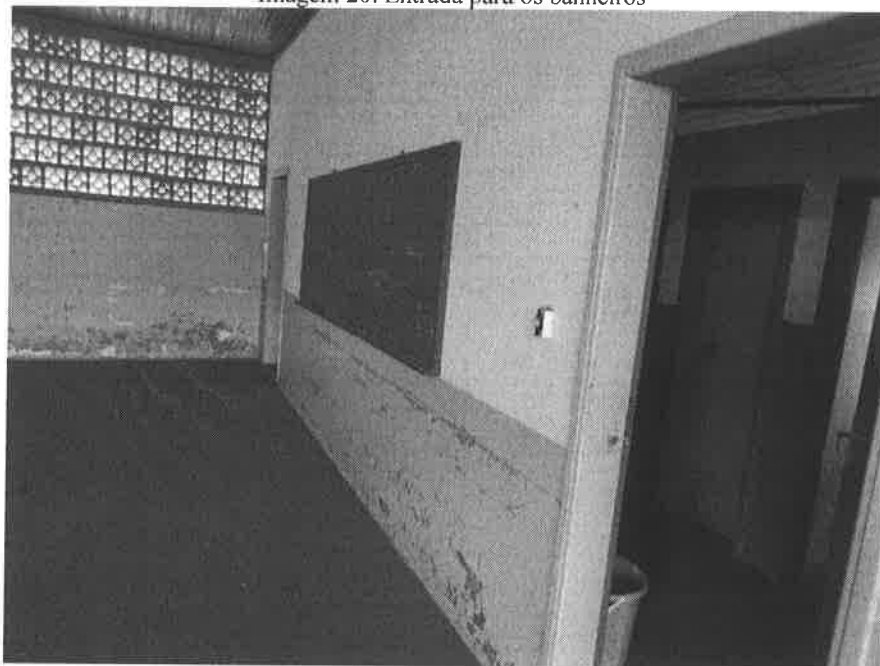
Imagem 20: Entrada para os banheiros
