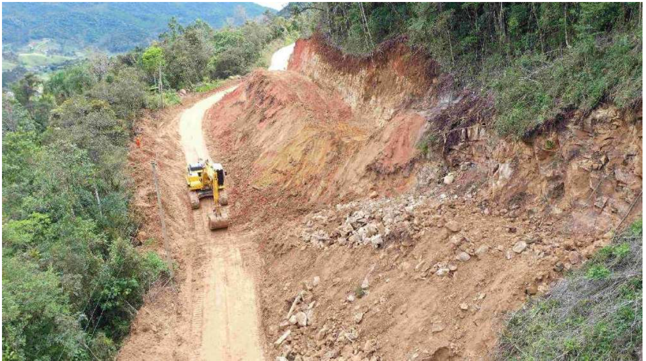
Foto 3 – Escavação de Material de 3ª Cat. km 44+900
