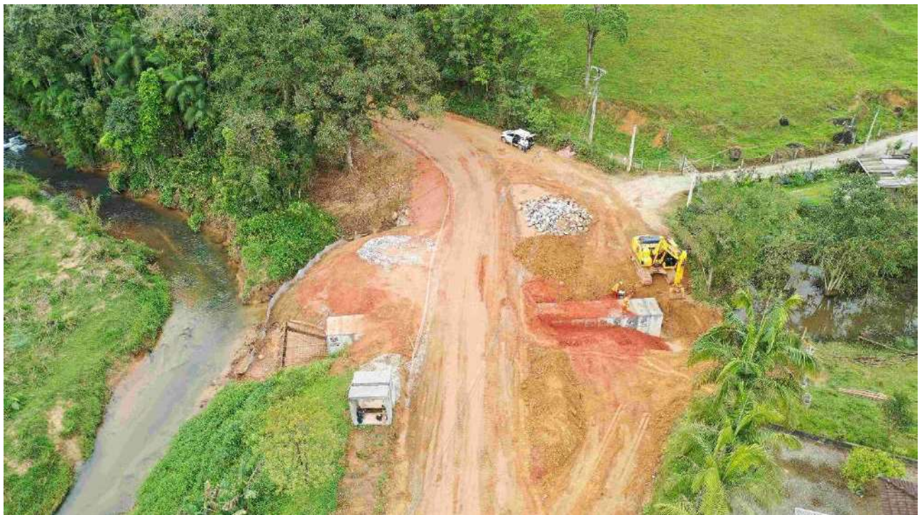
Foto 2 – Execução de BSCC 2,00 x 2,00 – 27+490
