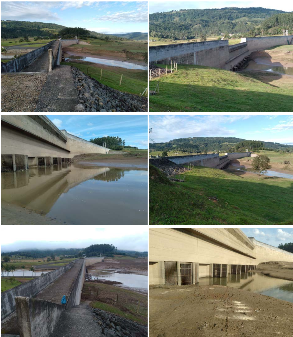
Figuras 13 à 18 - Estrutura de concreto - Vertedouro e barragem
