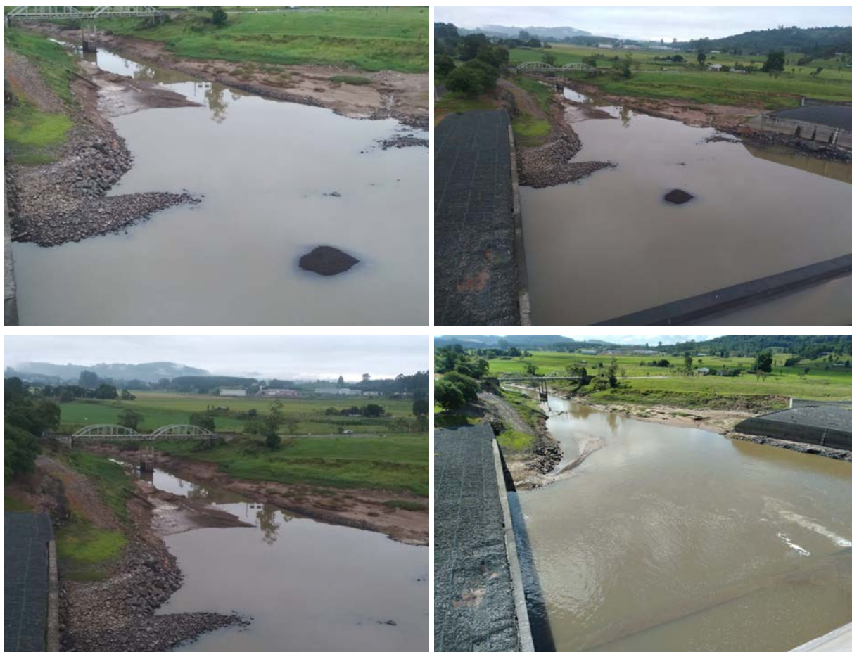
Figura 23 à 26 - Jusante do barramento - Área de restituição.
