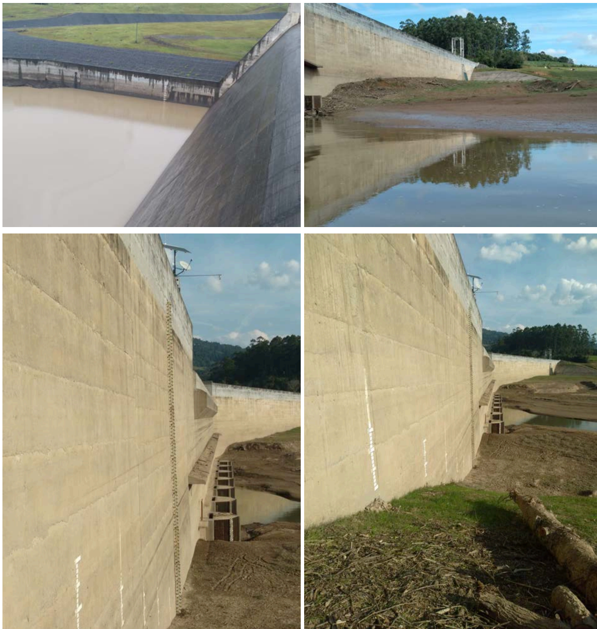
Figura 19 à 22 - Estrutura de concreto - Barragem e vertedouro - Primeira foto face de jusante as demais de montante.
