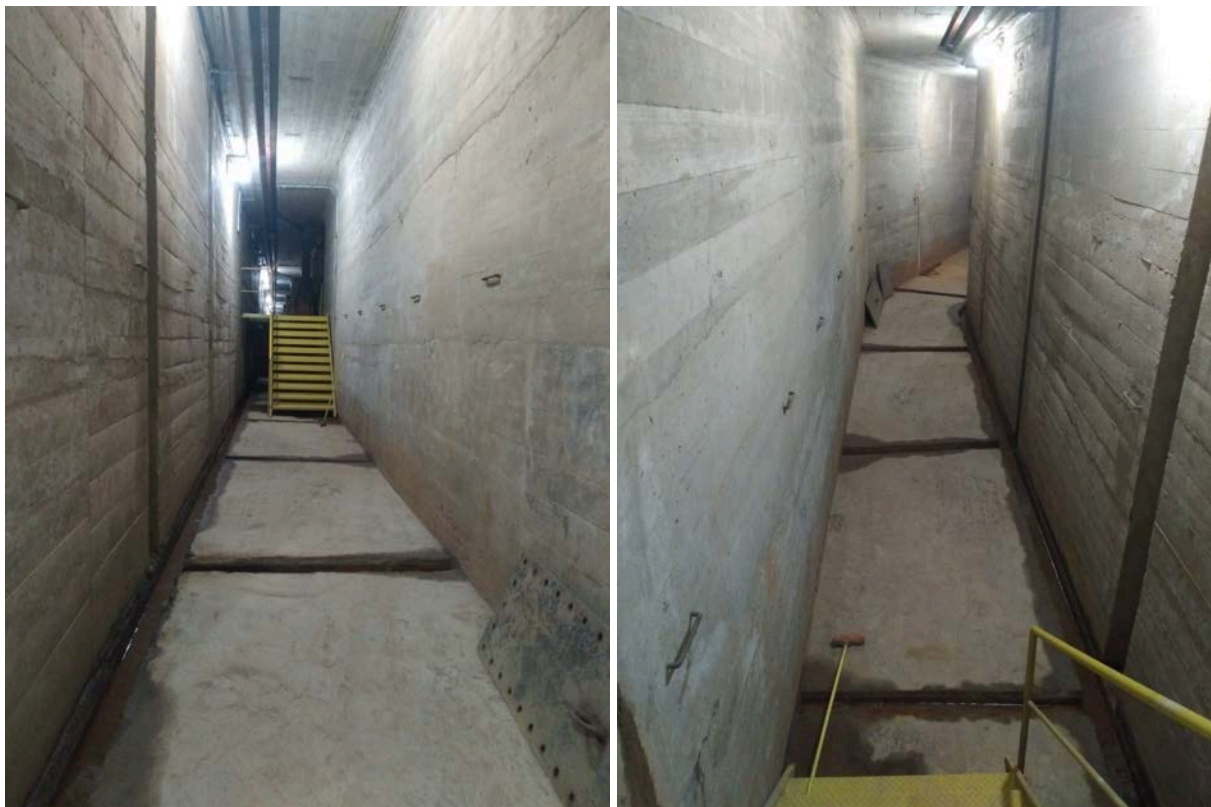
Figura 09 e 10 - Interior da Barragem - Detalhe da galeria interna
