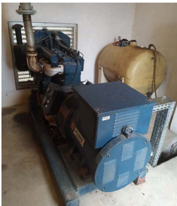
Figura 11 - Gerador auxiliar
