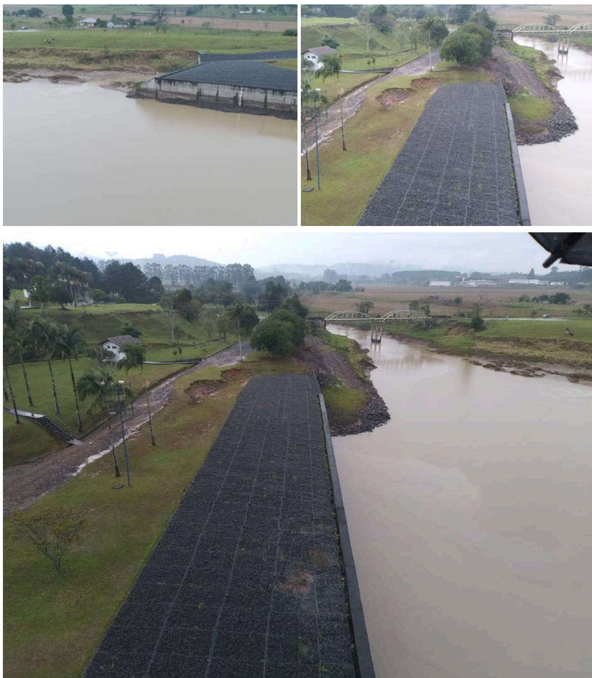
Figura 30 à 33 - Canal de restituição - Muros de transição
