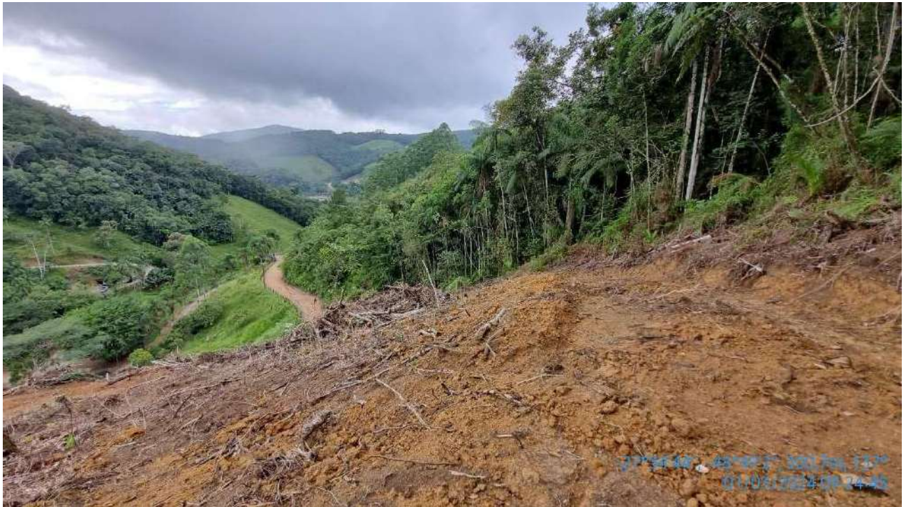
Serviços de Limpeza, corte de árvores e destocamento no km 24+060
