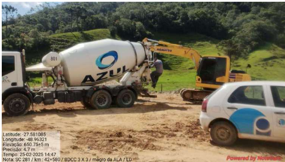
Inpetoria de Campo/Laboratório – Acompanhamento de Concretagem
