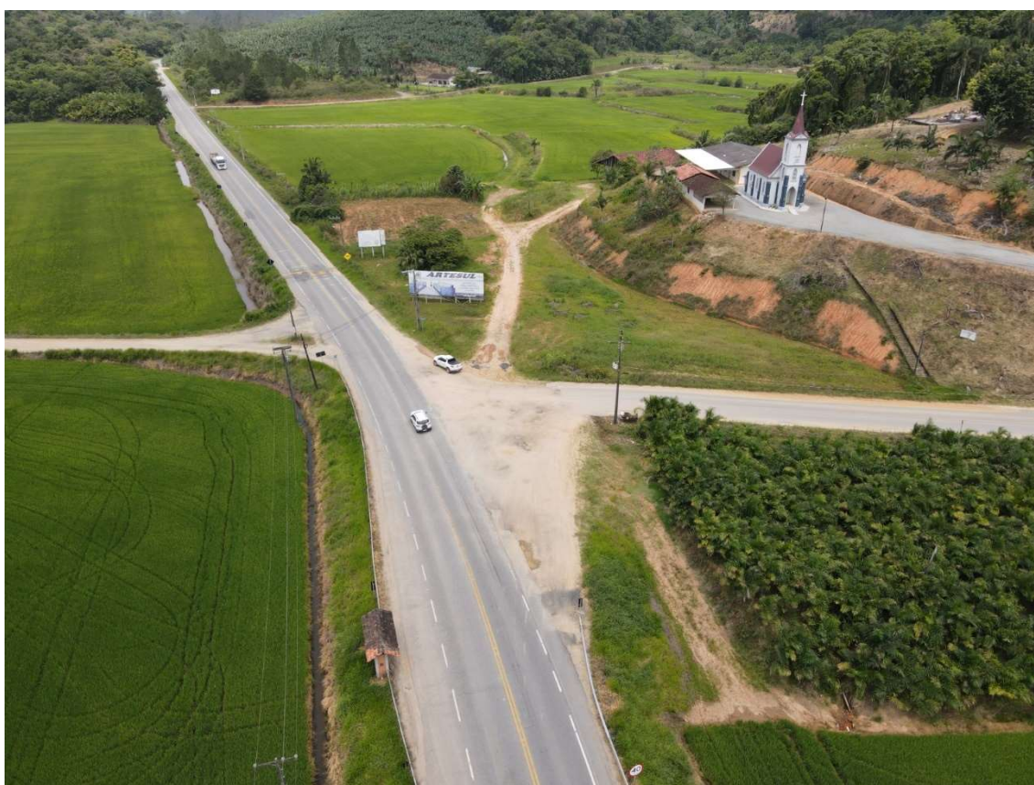
Figura 2 – Vista geral do local
