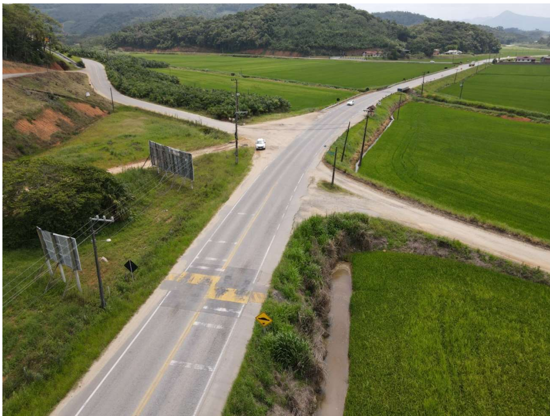
Figura 1 — Vista geral do local
