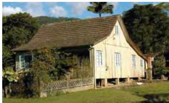
Casa de madeira, em Pomerode. A volumetria e a compartimentação interna permanecem as mesmas da casa enxaimel
