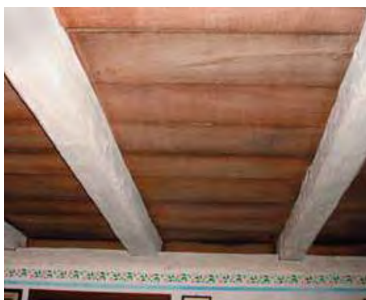
Na maioria das casas, o forro é formado pelo assoalho do sótão. Neste caso, o barroteamento fica aparente. De cima para baixo, casa Helmut Ulrich, Guabiruba; forro da cozinha, casa Norberto Zimath, Timbó; casa Helmut Lümke, Pomerode
