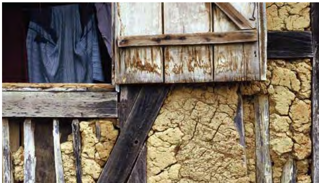
Detalhe de estrutura enxaimel preenchida com taipa de terra
