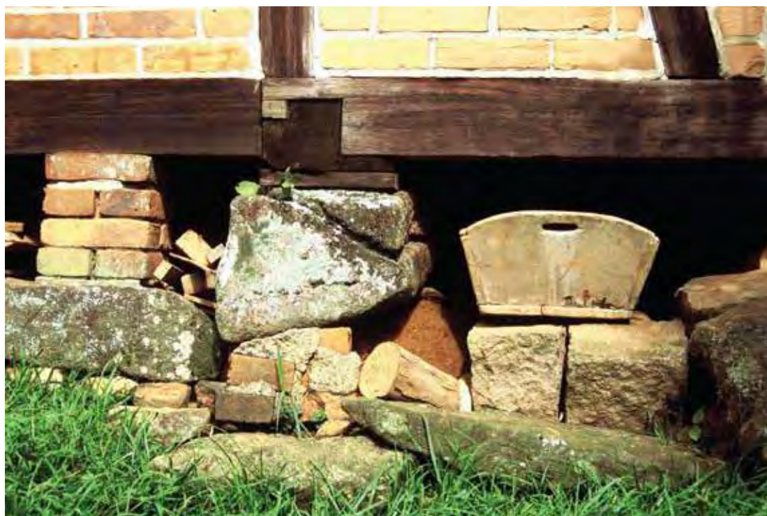
Utilização de pedras nas fundações: casa de taipa do Sítio Tribess, em Pomerode; Casa Harry Hein, em Blumenau, e Casa Radoll, em Timbó
