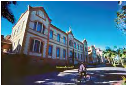
Fachada do Colégio São Paulo, no centro de Ascurra
