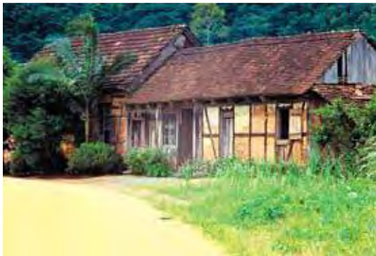
Antigo açougue Tribess (demolido), Testo Rega, Pomerode
