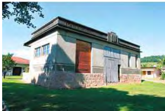
Estação Ferroviária de Warnow, em Indaial
