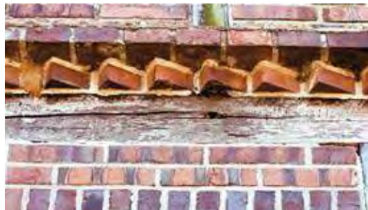
Colocação esmerada dos tijolos na empena da Casa Duwe, Indaial
