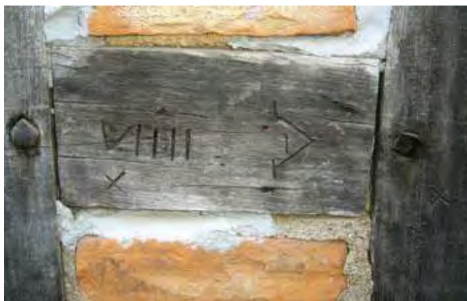
Detalhe de marcação das peças de madeira das estruturas enxaimel. A técnica consistia quase que numa estrutura pré-moldada, cujas peças eram previamente cortadas e assinaladas conforme a sequência construtiva a ser seguida no canteiro de obras
