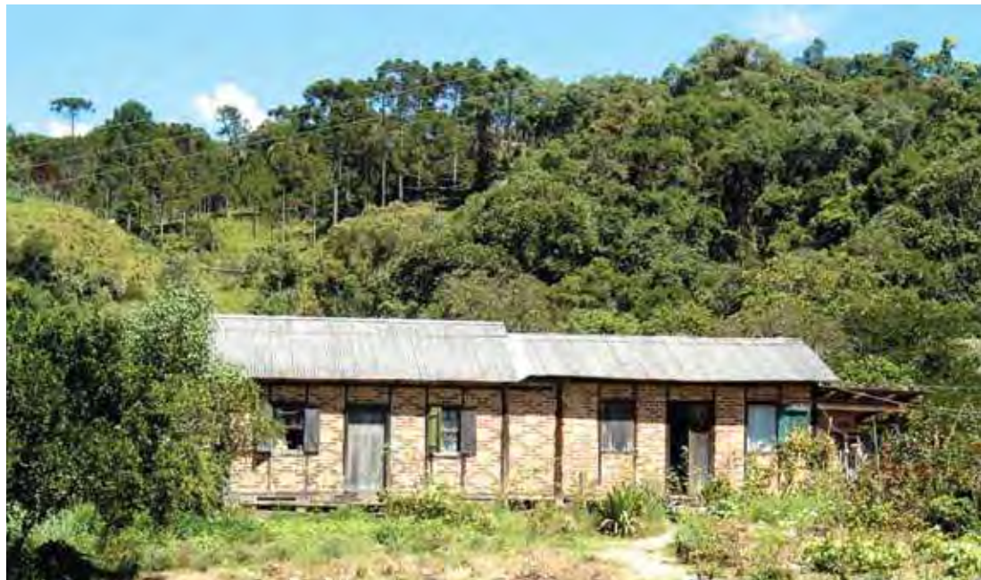
Casa em São Bonifácio, com cobertura de zinco, enxaimel simplificado e tijolos de tonalidades diferentes formando desenhos geométricos na fachada.
