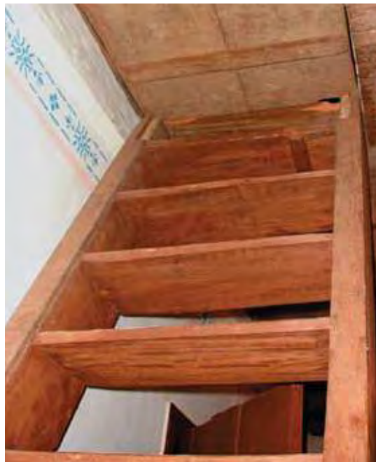
Escada que dá acesso ao sótão da Casa Helmut Lümke, em Pomerode. Simplicidade e grande inclinação caracterizam as escadas das casas teuto-brasileiras
