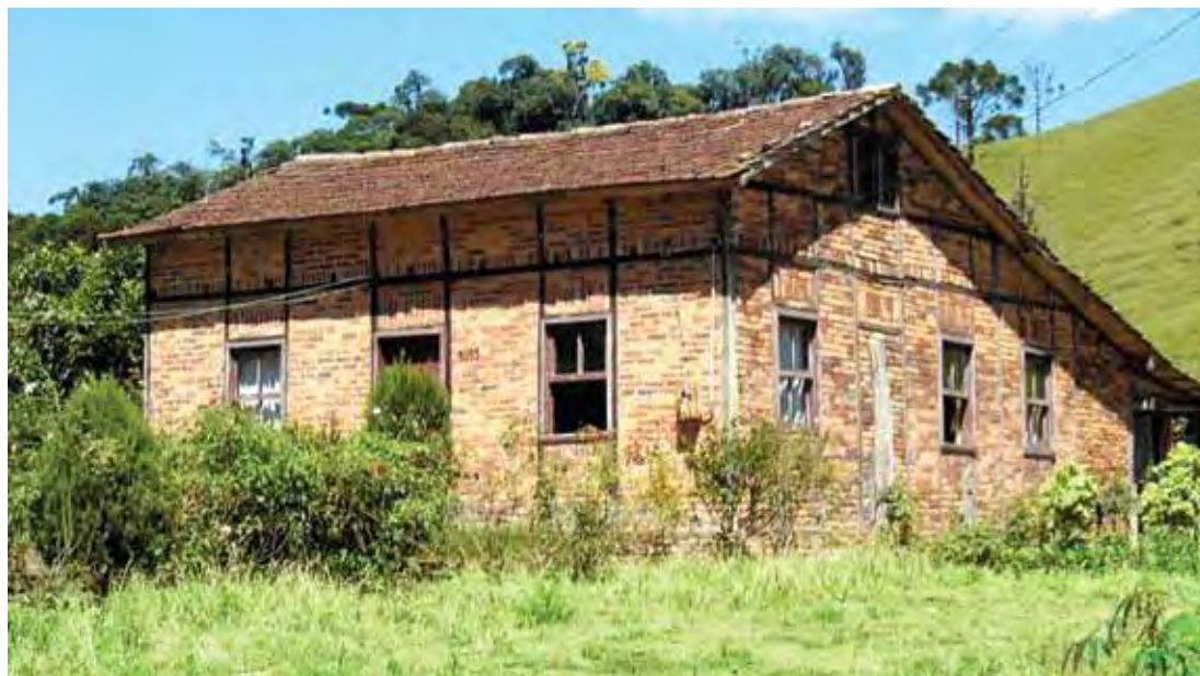
Casa em São Bonifácio. Enxaimel simplificado e pouca inclinação do telhado são características da região. Nota-se ainda o emprego de diferentes tonalidades de tijolos nos painéis enxaimel.
