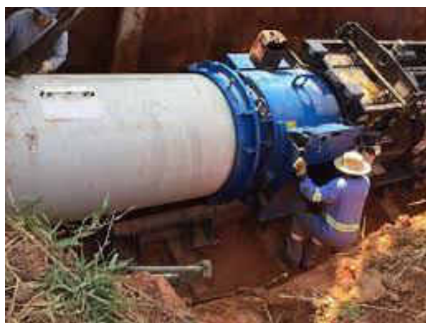
Figura 7.8: Tuneladora Cravando Tubo
