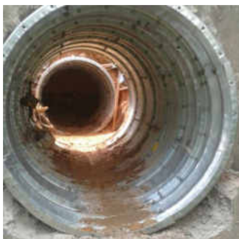
Figura 7.9: Túnel em Chapas de Aço Galvanizado e Módulos de Chapa
