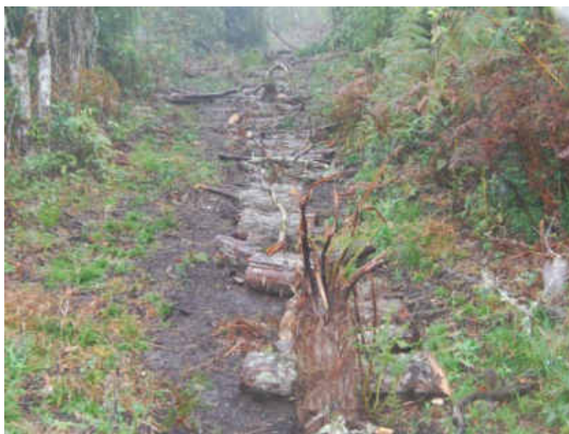
Figura 8.7: Exemplo De Controle Da Erosão Hídrica A Partir Do Uso De Toras, Galharias E Pedras
