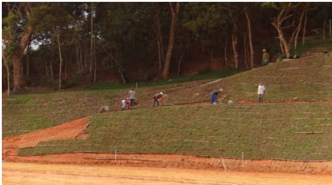
Figura 8.8: Plantio de Placas de Grama em Talude Utilizando Piquetes
