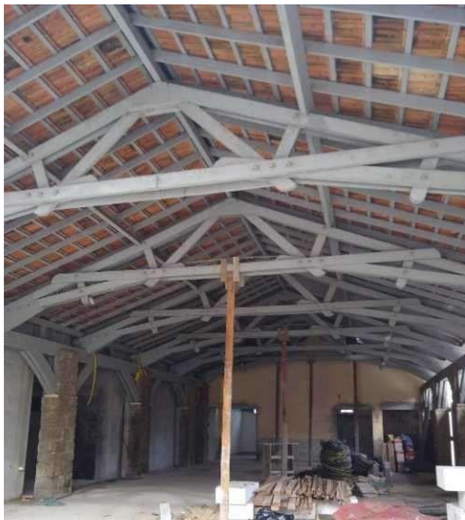
Cobertura a ser restaurada
