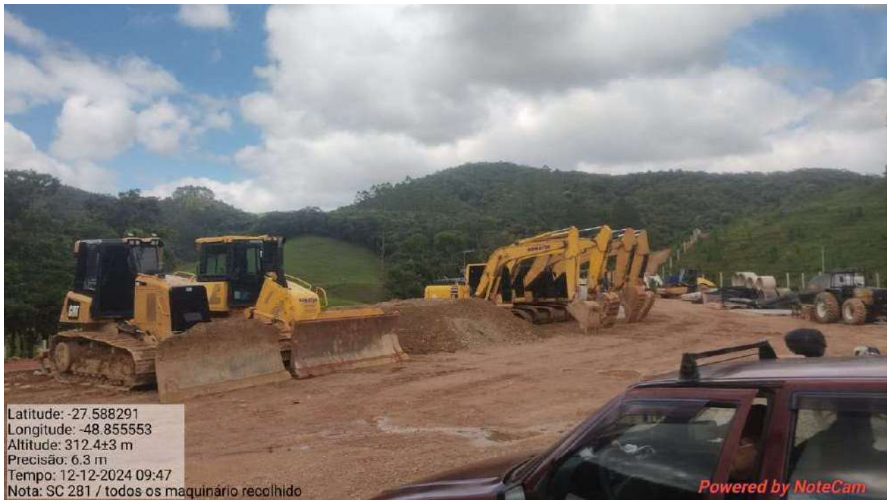
Foto 3 – Equipamentos no canteiro desde o dia 12/12/2024
