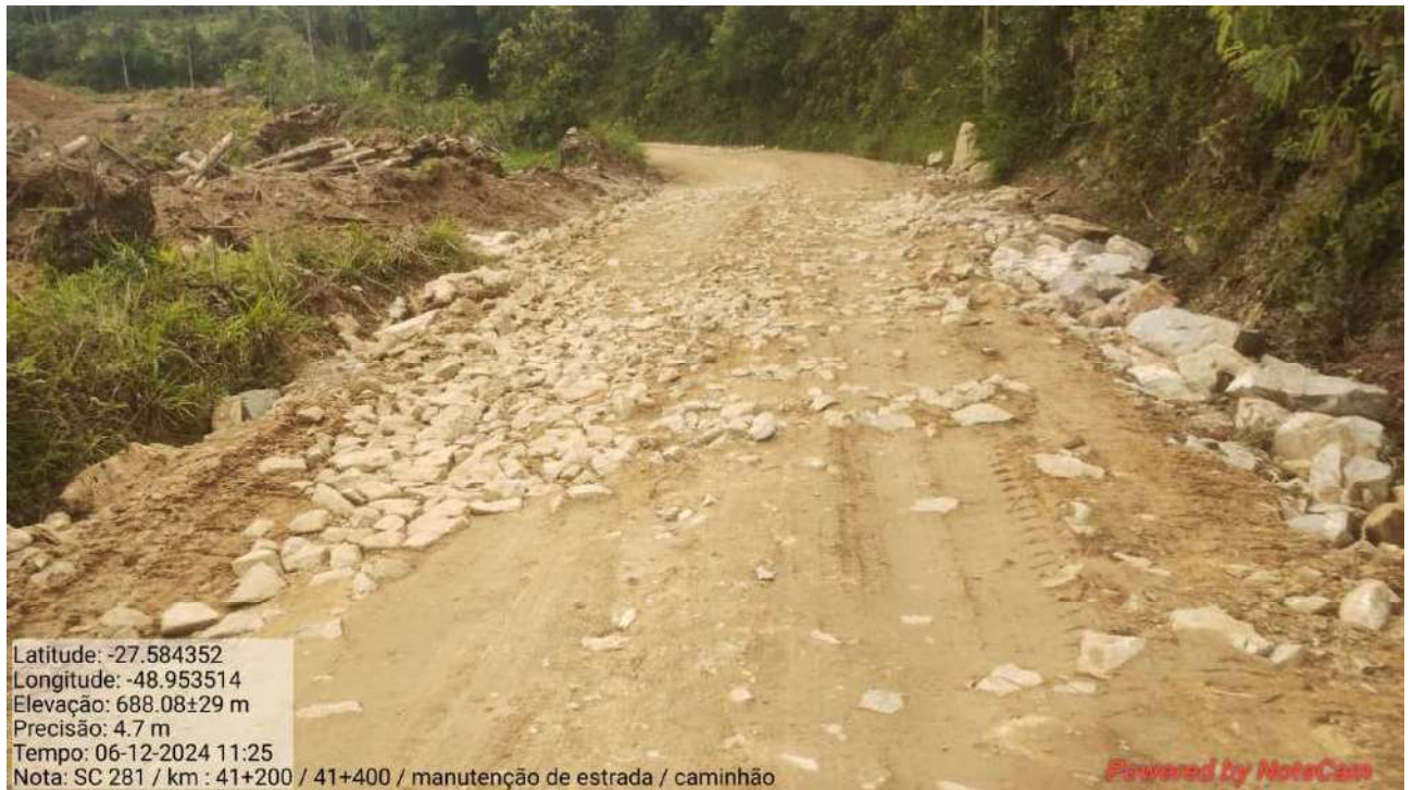
Foto 1 – Lastro de brita para manutenção 41+200
