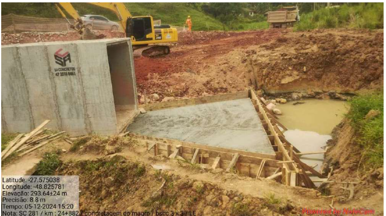
Foto 2 – Execução de berço/boca bscc 3,00 x 3,00 – 24+882
