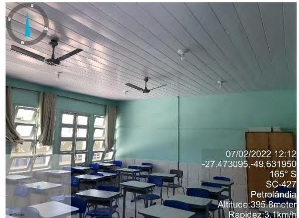
Fotos 11 e 12 – Laje em concreto armado e forro em PVC – salas de aula.
