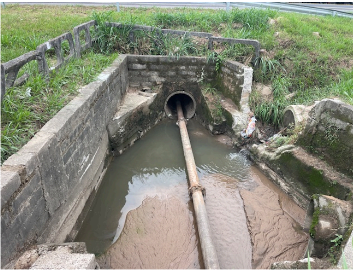
Foto 03 - Uma visão geral do local.
