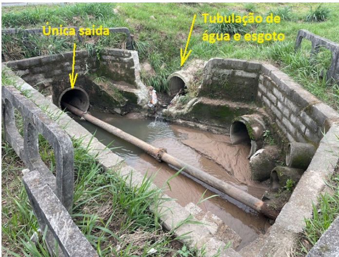
Foto 01 - Detalhe da única saída d'água e dos tubos de contribuição, inclusive o tubo de esgoto.
