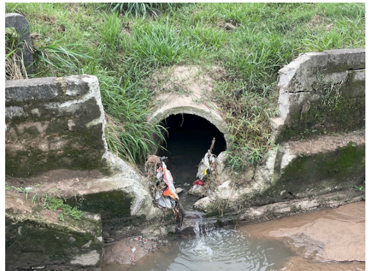
Foto 02 - Detalhe de parte da parede do bueiro executado pela prefeitura para conectar tubulação de água e esgoto.
