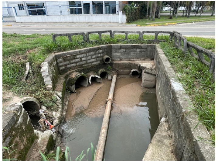
Foto 04 - Visão geral das demais tubulações (7) conectadas pela prefeitura.
