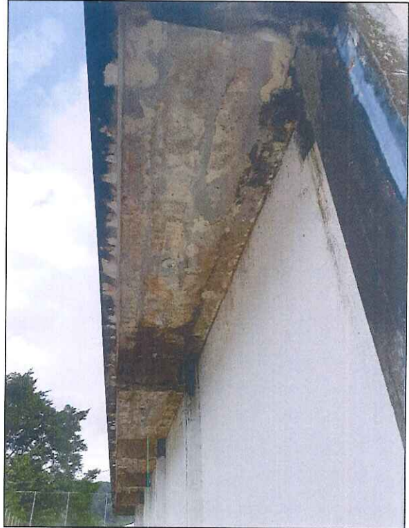
Figura 13 – Pilar com armadura exposta (Quadra)
