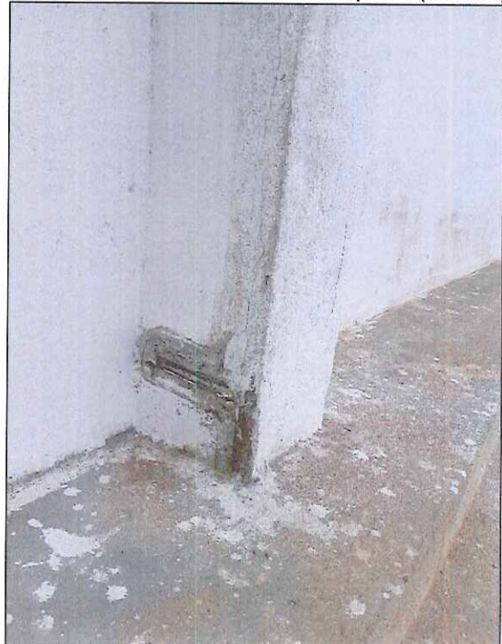
Figura 13 – Pilar com armadura exposta (Quadra)
