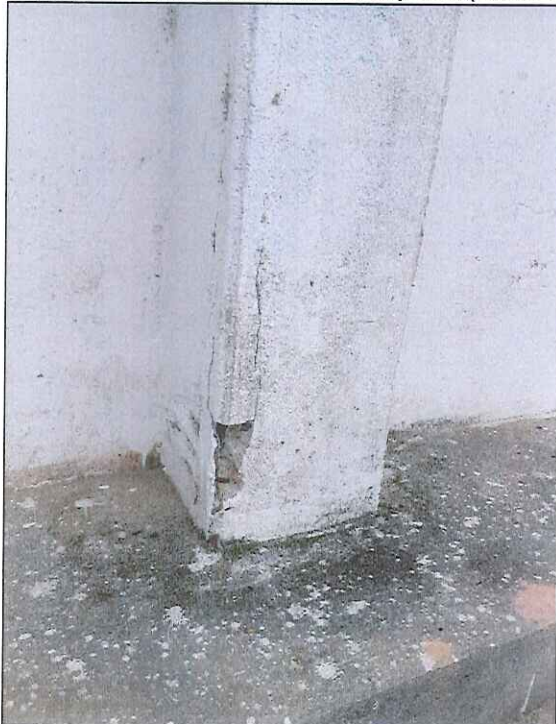
Figura 12 – Pilar com armadura exposta (Quadra)
