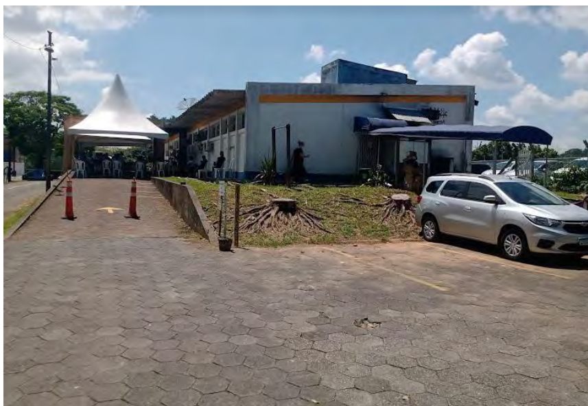
Figura 9 – Estacionamento e vista dos fundos
