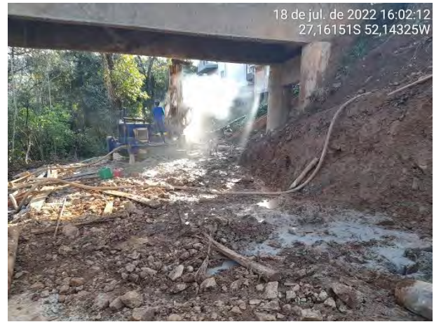
Foto 02 – Execução das fundações contensão
