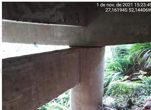
Foto 11 – Apoio da Mesoestrutura
