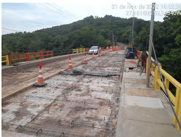
Foto 05 – Recuperação da pista de rolamento
