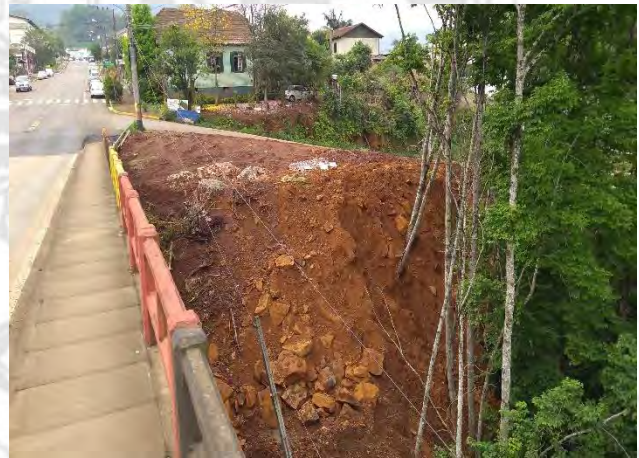
Foto 05 – Aterro Lateral Implantado
