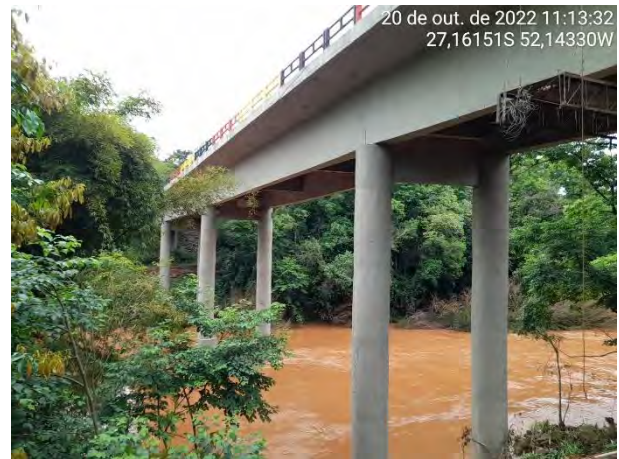
Foto 04 – Pintura da estrutura da Ponte
