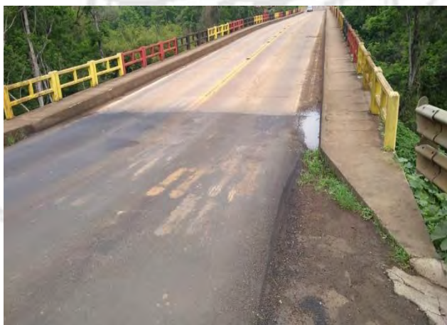
Foto 28 – Vista da Cabeceira Direita
