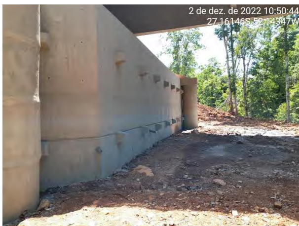
Foto 07 – Muro de contenção da cabeceira
