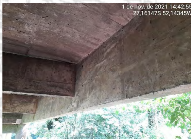
Foto 19 – Junta de Concretagem Viga Longarina
