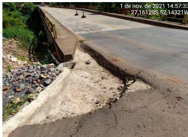
Foto 33 – Coleta das Águas Superficiais - Jusante
