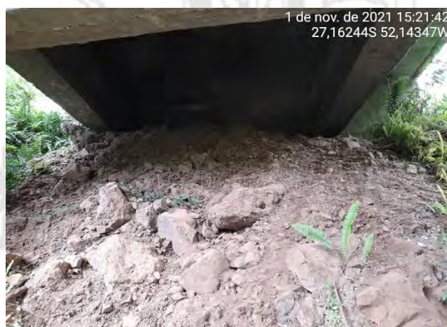
Foto 37 – Vista da Cabeceira Esquerda
