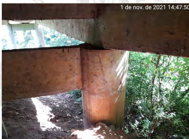
Foto 31 – Pilar Pórtico 01 – Montante
