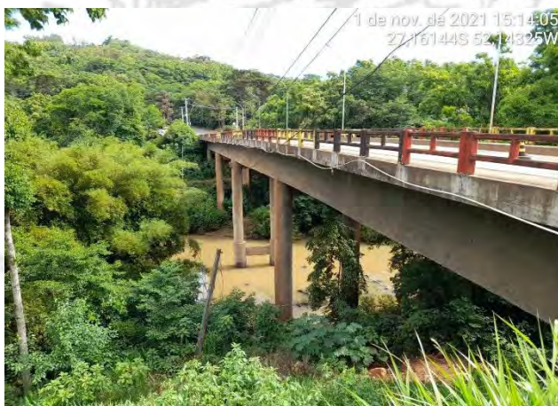
Foto 18 – Vista da Ponte - Jusante
