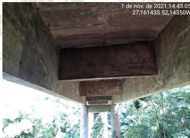
Foto 15 – Vista Vigas Longarinas e Transversinas
