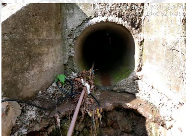
Foto 30 – Vista Sistema de Drenagem - Montante
