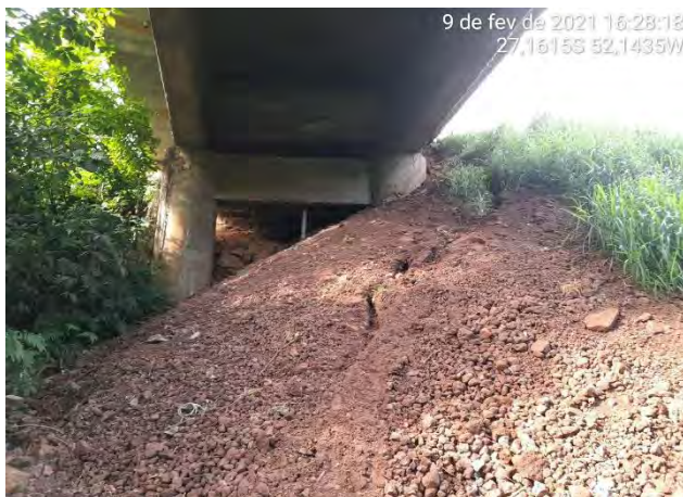
Foto 08 – Aterro Lateral + Mesoestrutura
