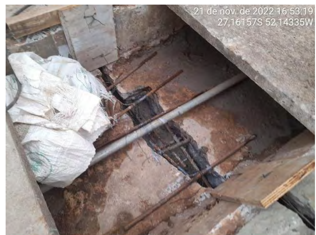
Foto 06 – Recuperação da estrutura da Ponte
