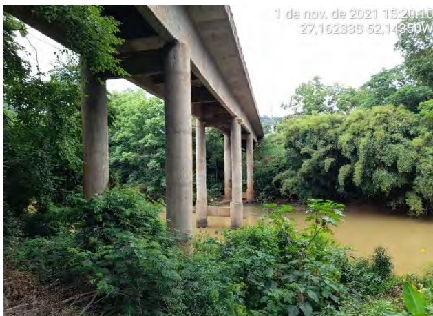
Foto 10 – Mesoestrutura a Jusante
