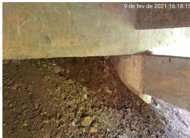
Foto 09 – Aterro Lateral + Mesoestrutura
