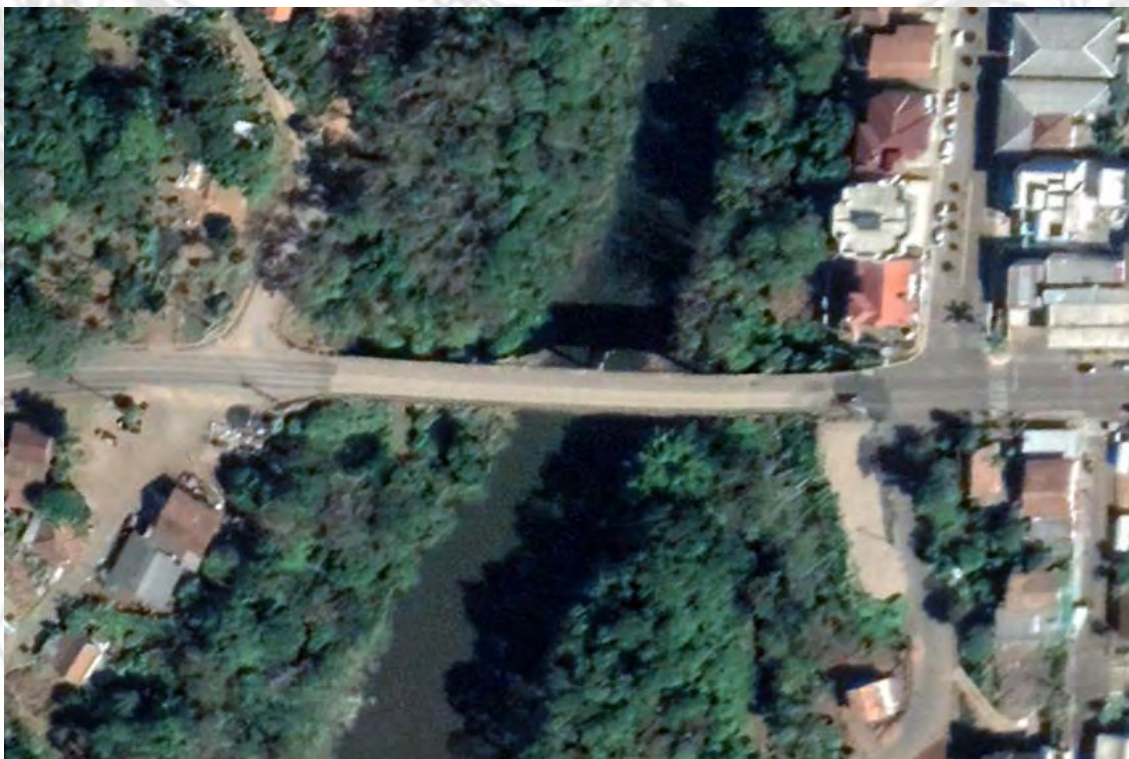
Figura 1: Vista Aérea do Trecho – Fonte Google Earth
