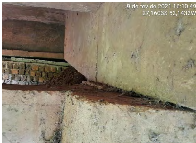
Foto 26 – Vista do aparelho de Apoio
