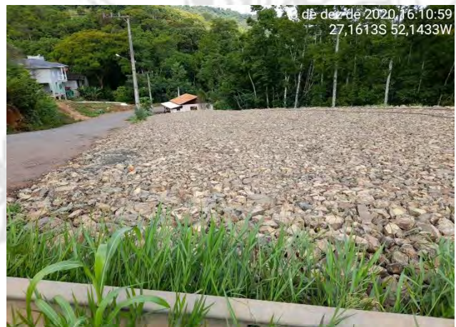
Foto 07 – Acabamento do Aterro Lateral
