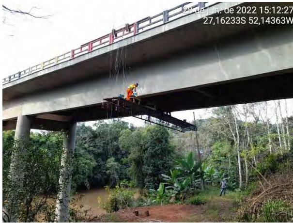
Foto 01 – Limpeza e pintura da estrutura
