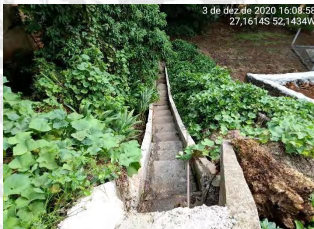
Foto 29 – Vista do Sistema de Drenagem
