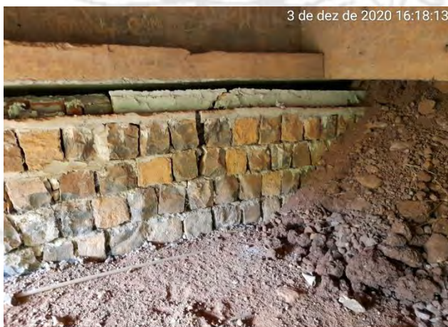
Fotos 01, 02 e 03: Evolução da deformação do muro de contenção
