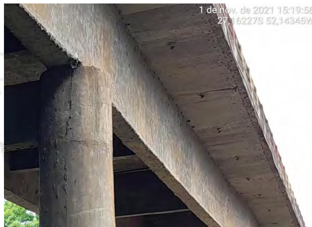
Foto 17 – Vista das Vigas e Passarela
