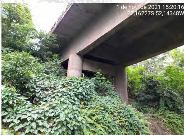
Foto 36 – Vista do Pórtico 06 - Jusante
