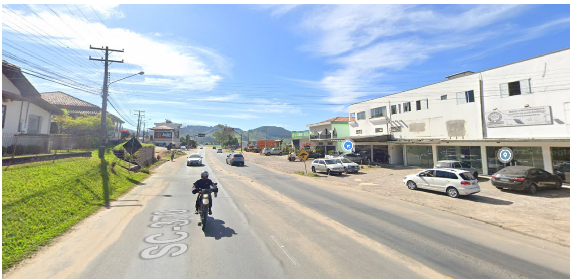
Rodovia com presença de rampas de acesso conduzindo as águas em excesso para a rodovia.
