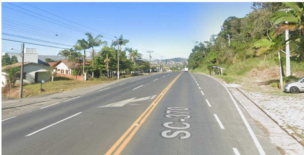
Faixa de domínio sendo utilizada para implantação de ponto de ônibus e abrigo de passageiro.
