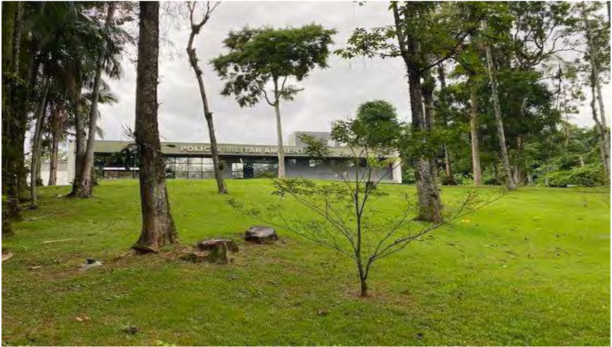
Foto 3 – Vista da elevação frontal imóvel avaliando
