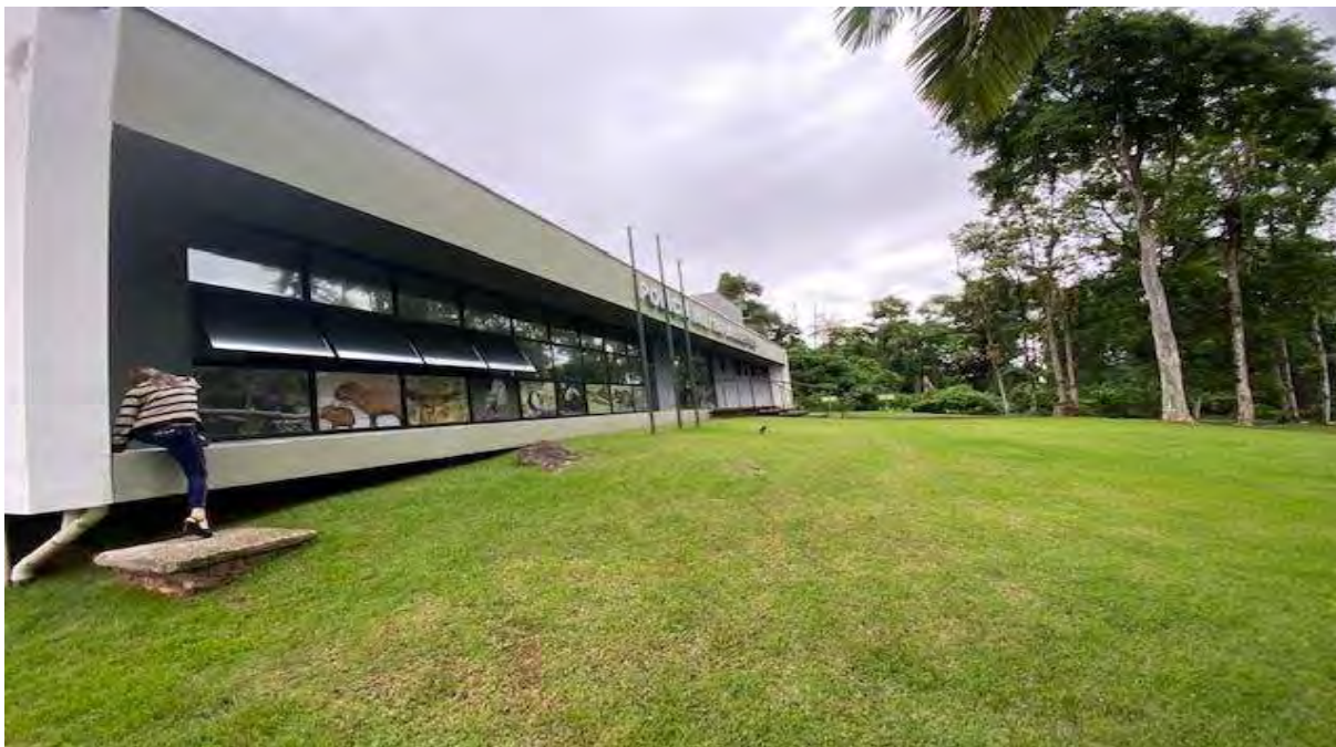
Foto 5 – Fachada lateral do Sigep 4975
