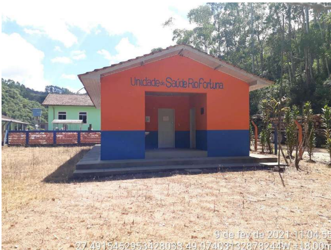
Imagem 1 - Vista do imóvel em 09/02/21
