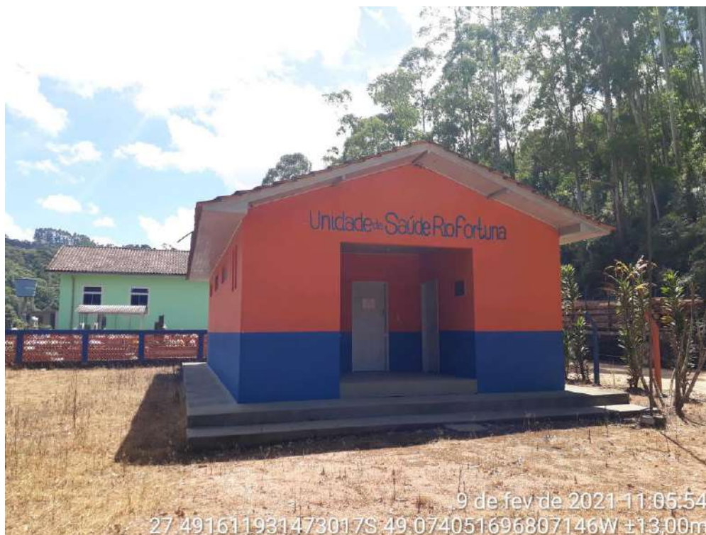
Foto 2 – Vista do Imóvel
