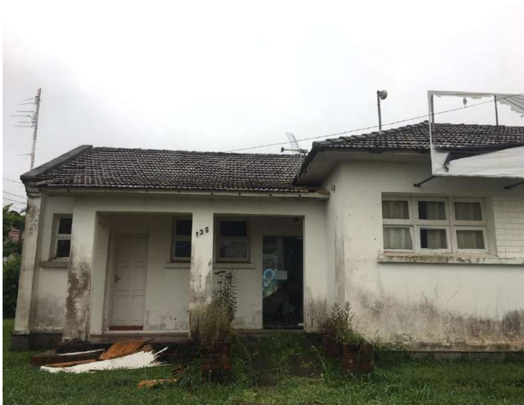
Foto 1 – Vista do imóvel
