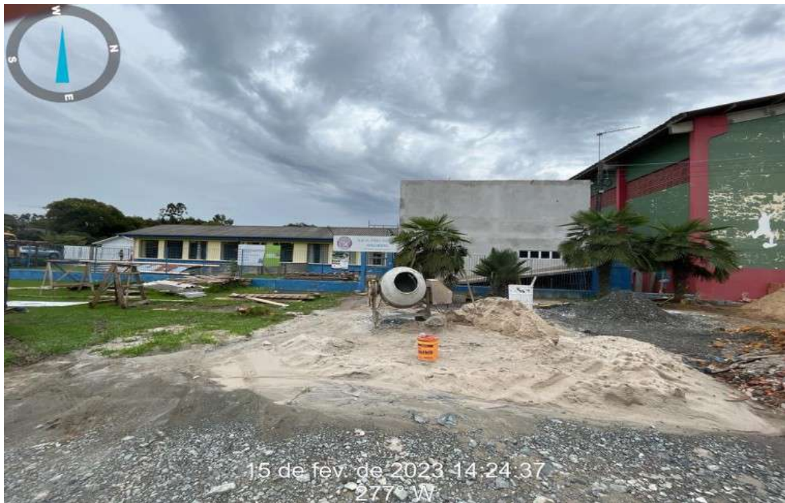
Foto 1 – Vista do imóvel
