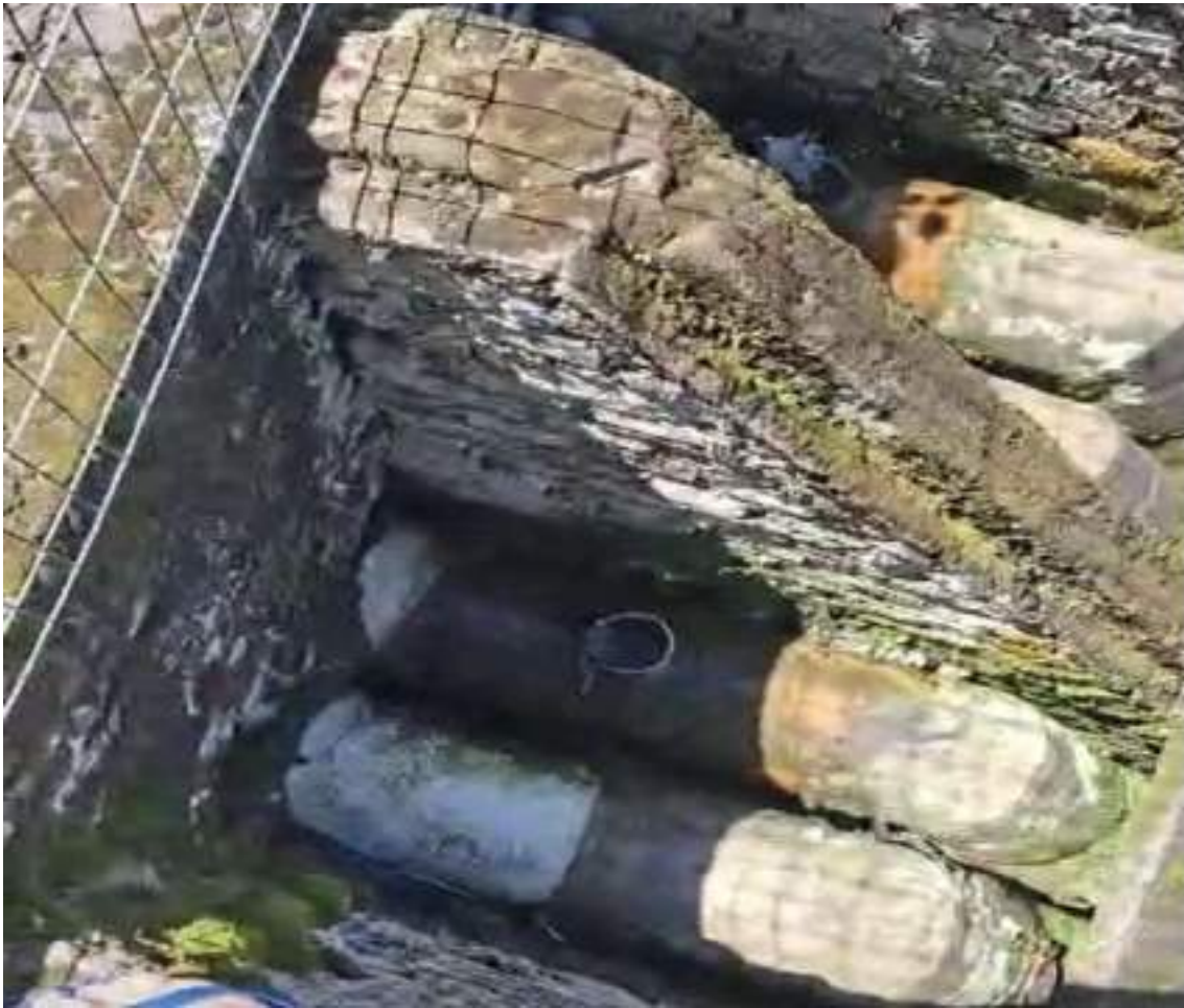
Foto 07: Sistema de canalização de captação hídrica de cada turbina direcionada ao canal artificial concreto.
