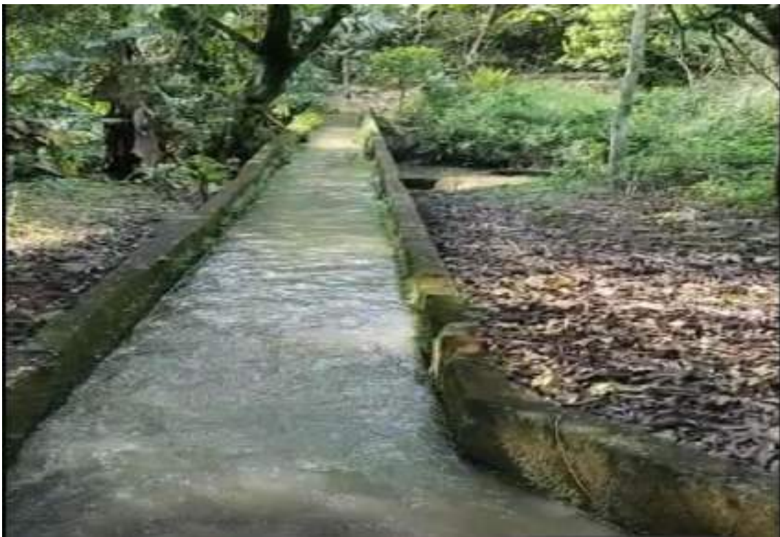
Foto 08: Cana artificial de distribuição para irrigação
