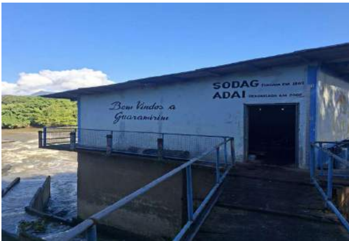
Foto 01: Casa de Máquinas
