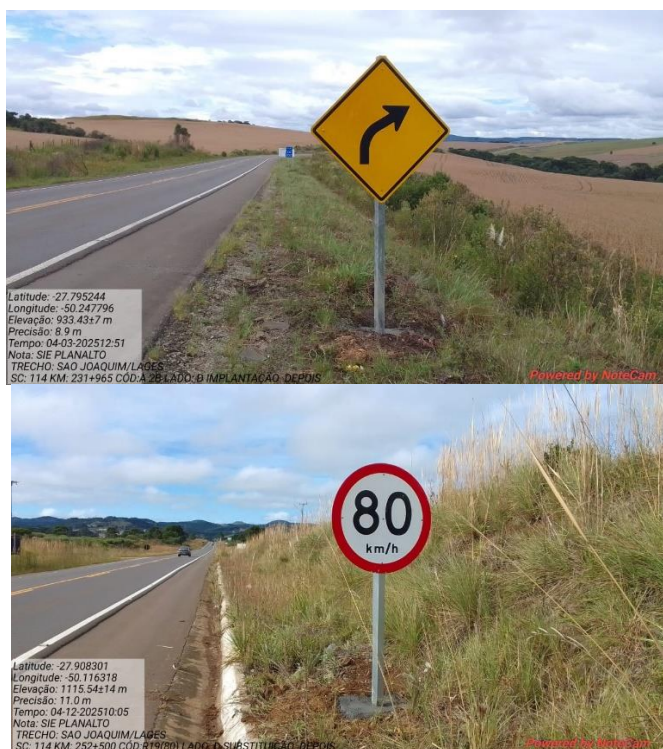
Sinalização vertical implantada
