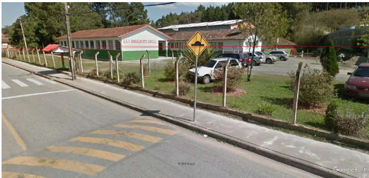
Foto 3 – Elevação frontal do Sigepe 1069 – Imagem Google Earth
