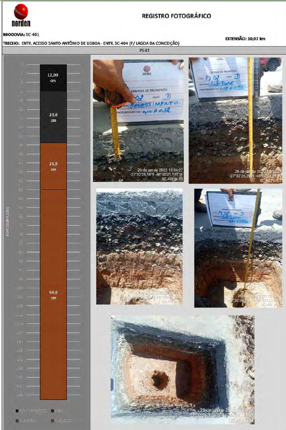
Relatório Fotográfico das amostras dos Poços de Inspeção (2)
