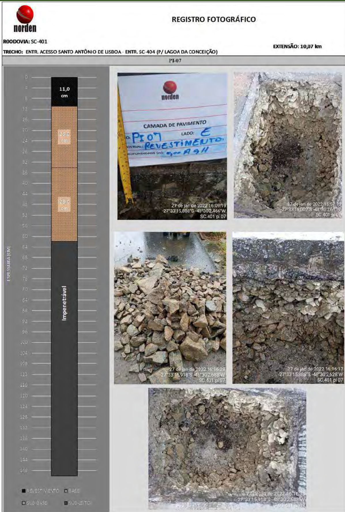
Relatório Fotográfico das amostras dos Poços de Inspeção (7)
