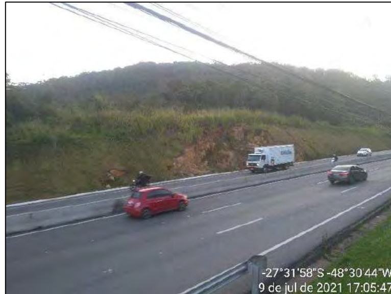
Figura 3.2.15 – Registro Fotográfico do Talude em Estudo (Km 13,73)
