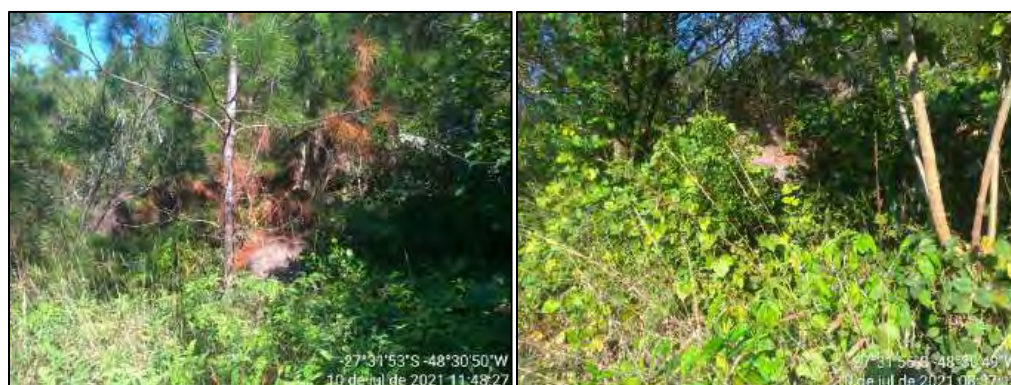
Figura 3.2 18 - Blocos de rocha apoiado sobre vegetação arbórea
