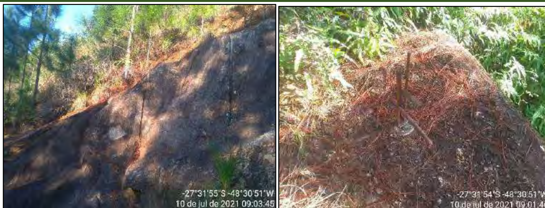
Figura 3.2.17 – Registro de perfuração para quebra de blocos (esquerda) e de grampos verticais em matacões (direita).
