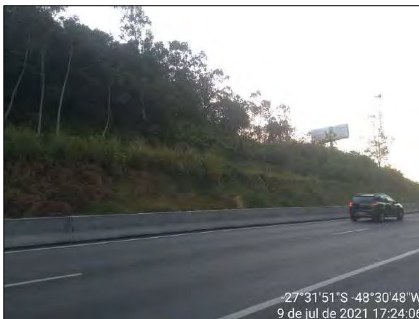
Figura 3.2 11 - Placas de grama na face do talude de corte. Em regiões horizontalizadas são observadas vegetação primária e na encosta é observada Mata Atlântica
