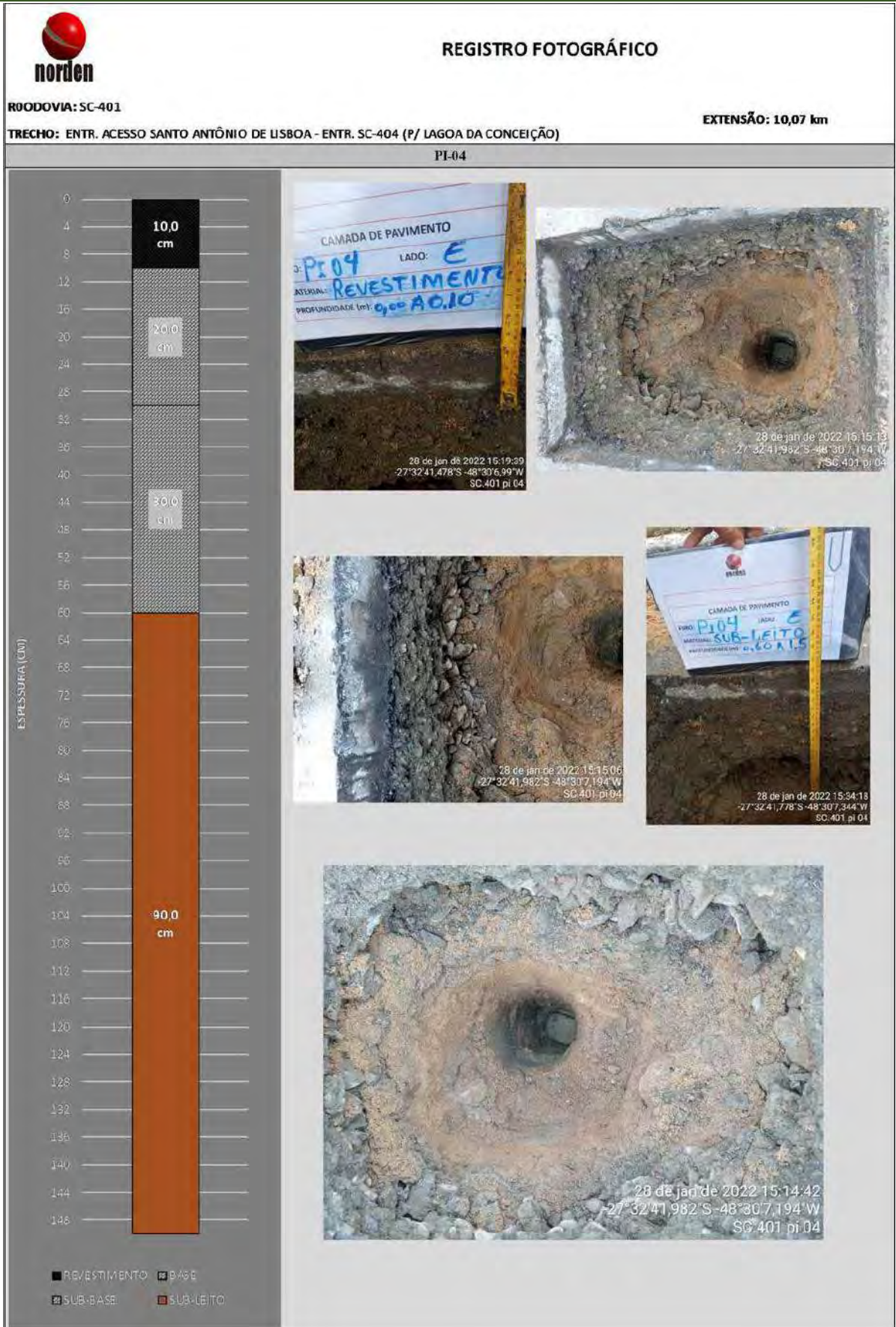
Relatório Fotográfico das amostras dos Poços de Inspeção (4)
