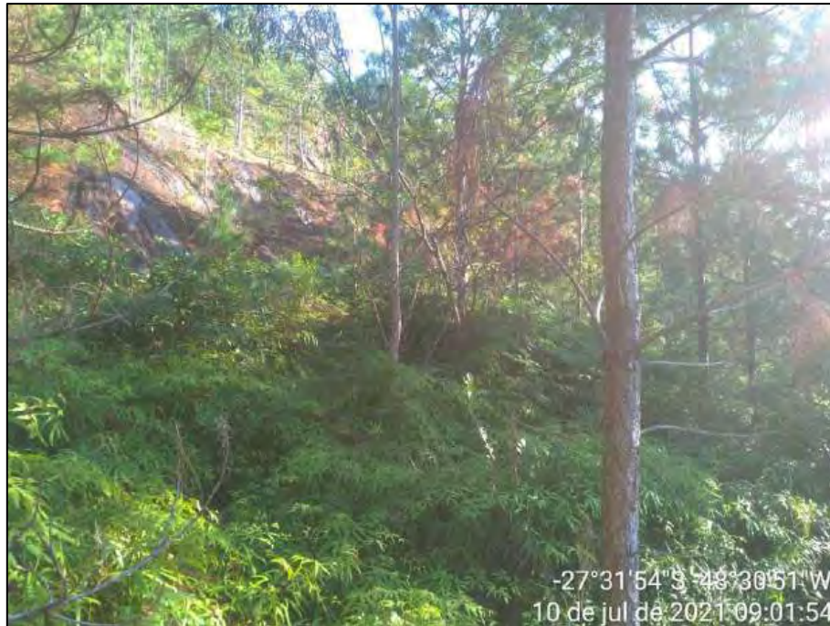
Figura 3.2 12 - Região de maior altitude no talude entre os km 13+500 e 14+000, lado direito.
