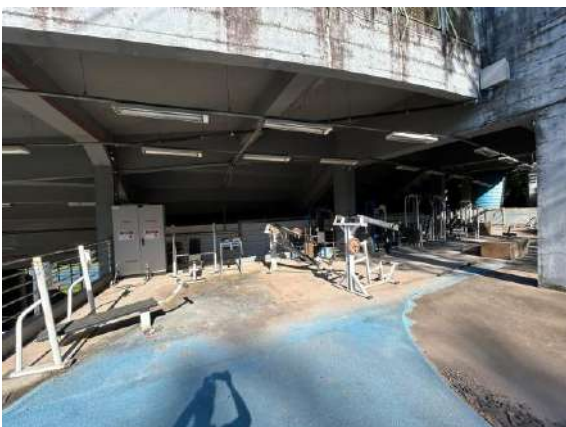
Foto 27 – Parte inferior das arquibancadas.
