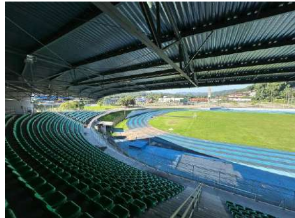
Foto 24 – Arquibancadas do estádio.
