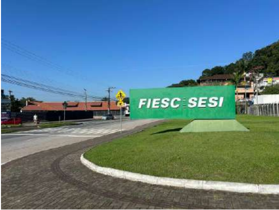
Foto 1 – Fachada do Imóvel.
