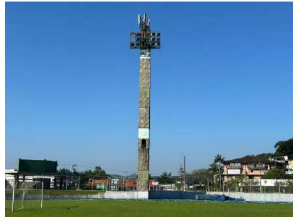
Foto 30 – Torre de Iluminação.
