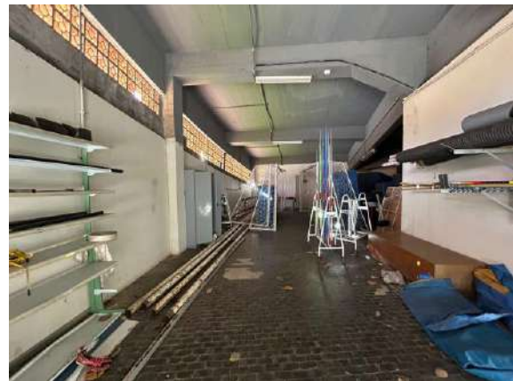
Foto 26 – Parte interior das arquibancadas.
