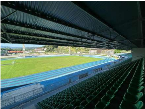
Foto 23 – Arquibancadas do estádio.
