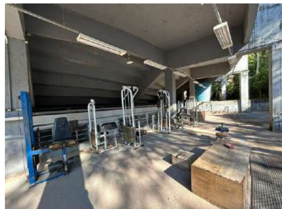
Foto 28 – Parte inferior das arquibancadas.
