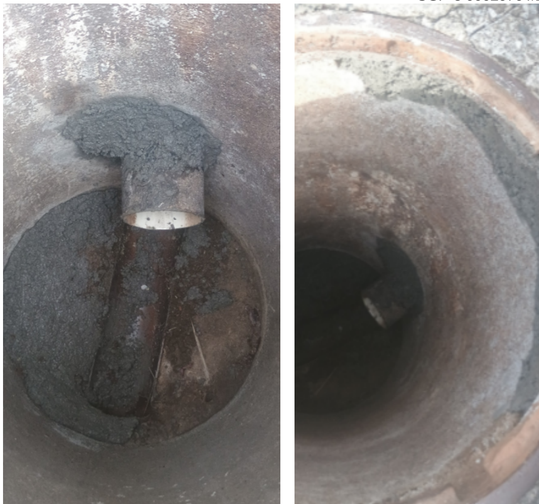
Figura 2 – Correção das infiltrações realizada no dia 02/05/2025.
