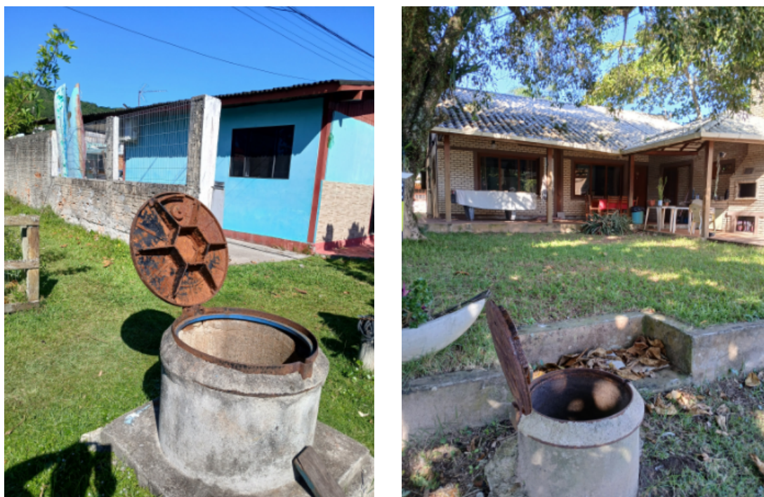
Figura 1 – Vistoria técnica realizada no dia 29/04/2025.
