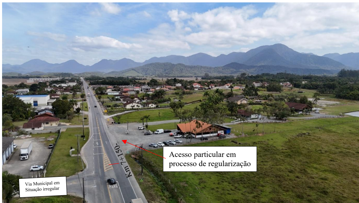
Figura 3- Situação do local nas imediações km 7+150 SC-108
