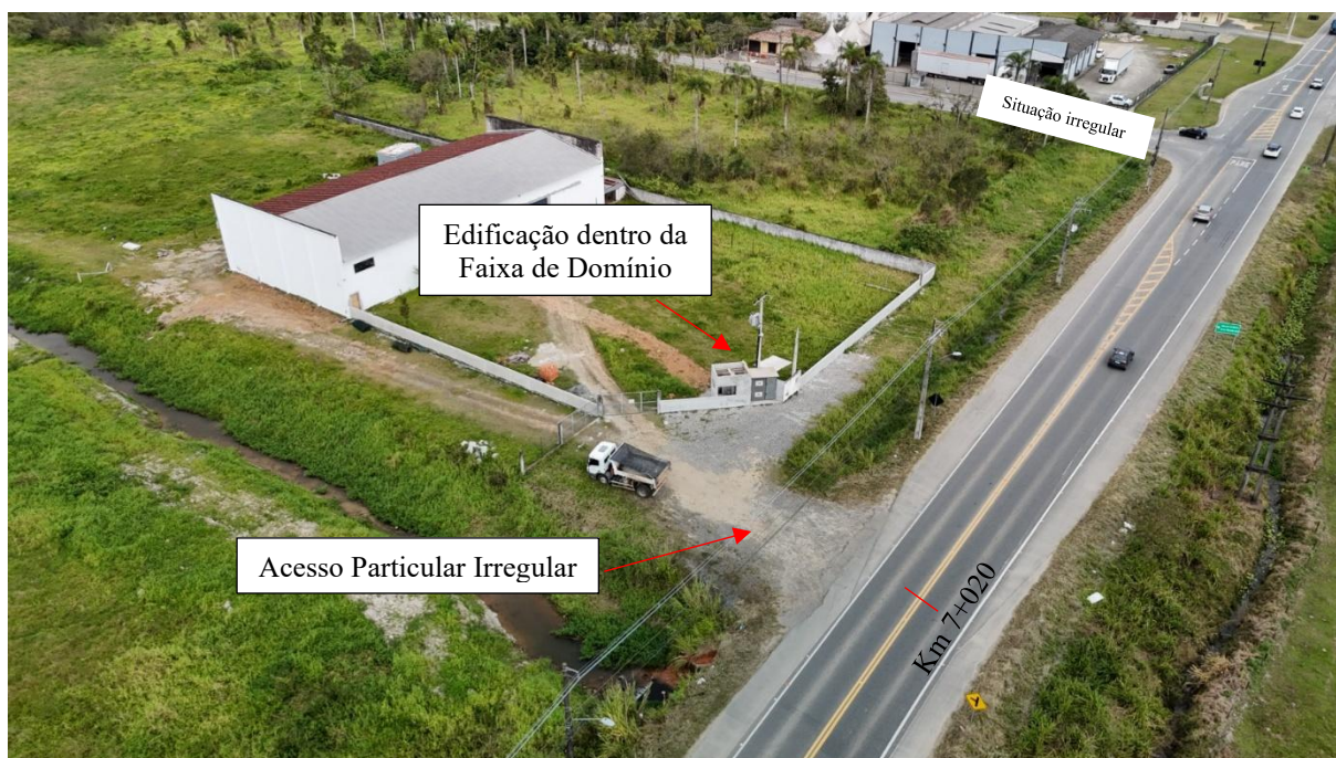
Figura 2- Situação do local nas imediações km 7+020 SC-108
