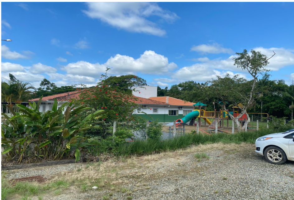
Foto 1 – Vista do imóvel
