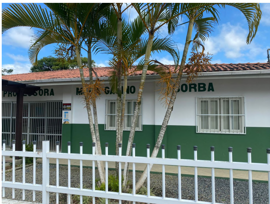
Foto 2 – Vista do imóvel
