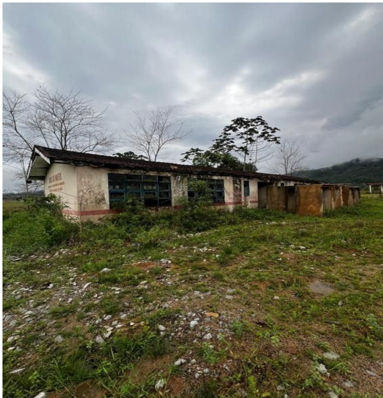
Figura 3 – Foto da fachada frontal tirada in loco no 20 de setembro de 2020
