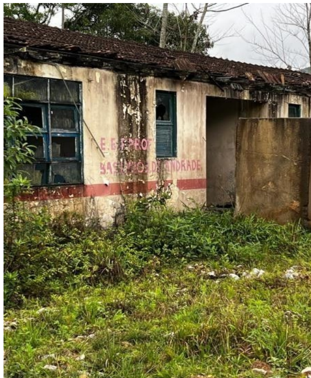
Figura 1 – Foto da fachada frontal tirada in loco no 20 de setembro de 2020
