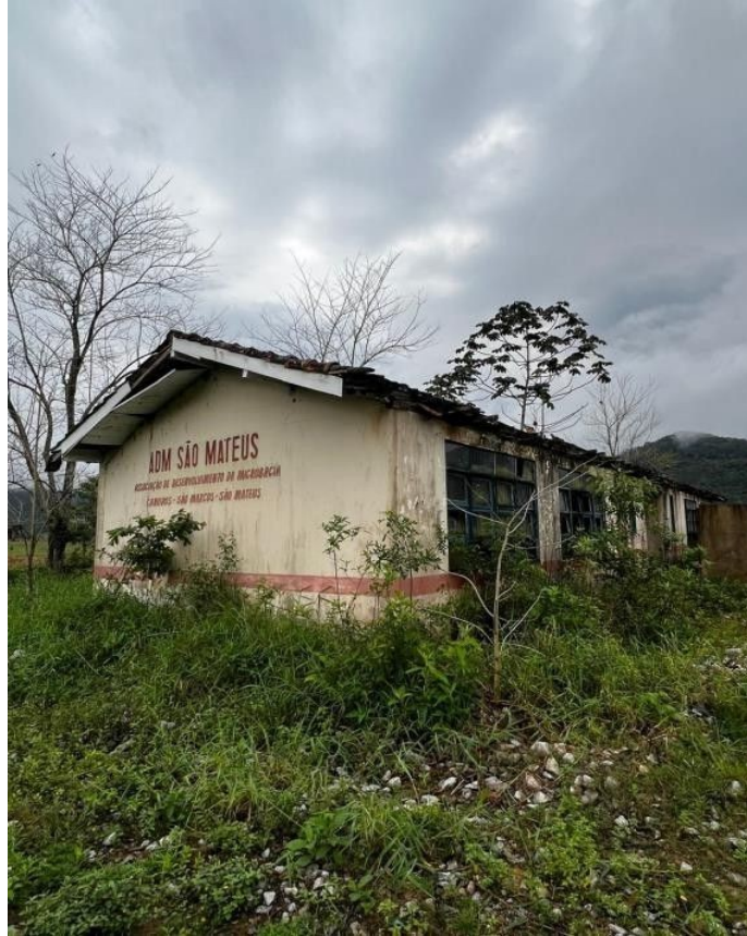
Figura 2 – Foto da fachada norte tirada in loco no 20 de setembro de 2020
