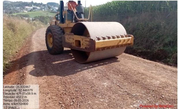
FT 02 – Manutenção da SC 479 – ABR/2026
