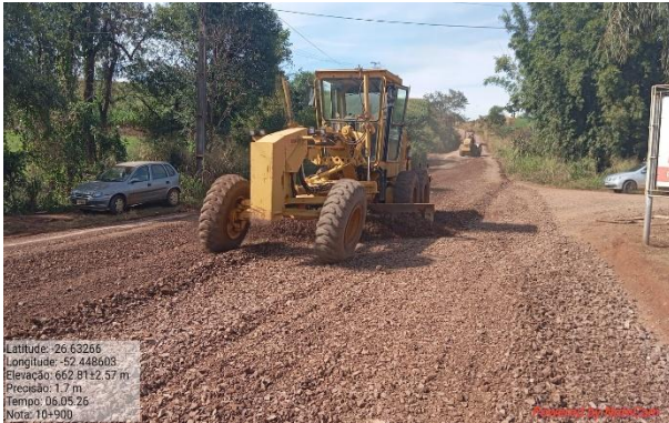
FT 01 – Manutenção da SC 479 – ABR/2026
