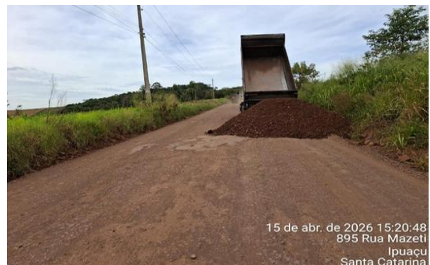
FT 06 – Manutenção da SC 479 – ABR/2026
