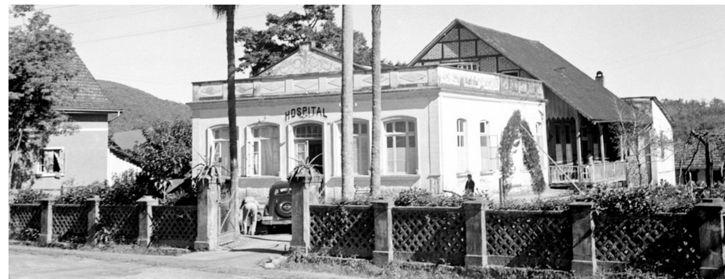
EM 1876 FOI CONCLUÍDA A EDIFICAÇÃO E PASSOU A DENOMINAR-SE "HOSPITAL DA CARIDADE".
