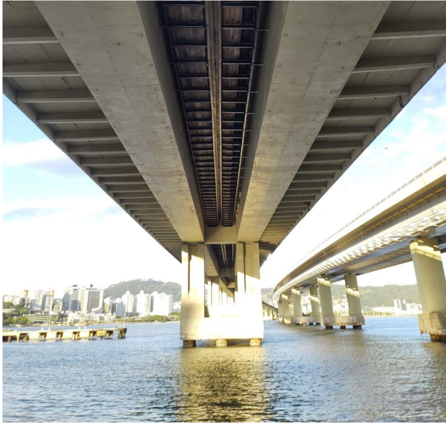
Figura 8 - CONTINENTE - Ponte Colombo Machado Salles: Extremidade continental possui passarela com estrutura completa em ambas as laterais, sendo a norte contínua e a sul parcialmente existente
