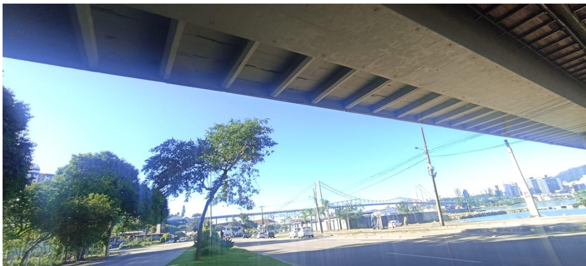
Figura 15 - Passarela (lado norte) sobre a via, na extremidade continental
