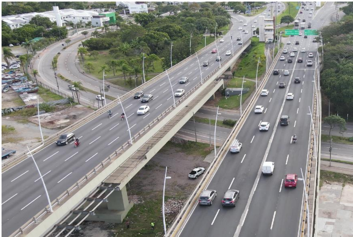
Figura 33 - Elementos remanescentes da passarela de concreto na ponte Pedro Ivo Campos, lateral norte
