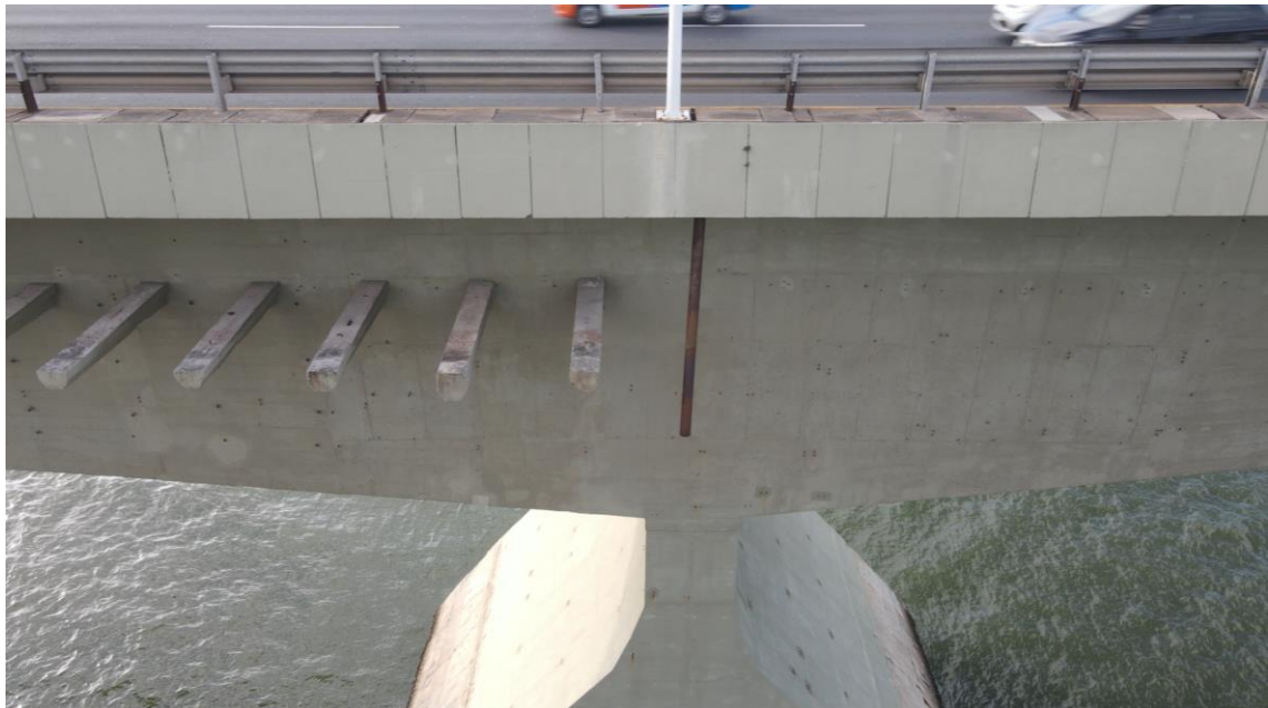
Figura 23 – Eixo do Bloco 7, transição entre o trecho com vigas e o trecho sem, onde essas foram removidas em contratação anterior
