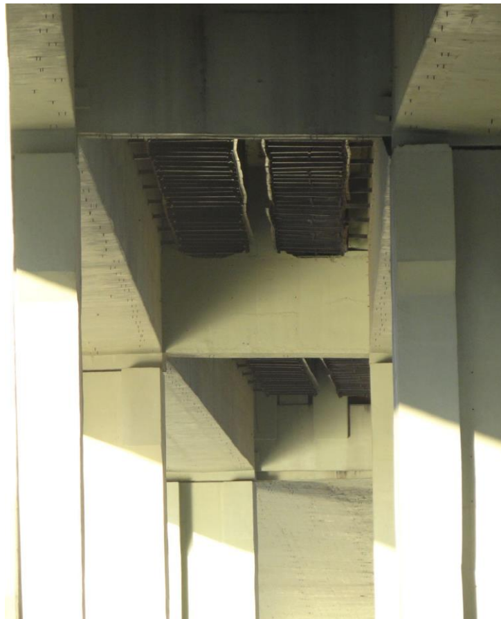
Figura 27 - Vista inferior da passarela de serviço e sua continuidade na transição entre as vigas independentes e a viga caixão central
