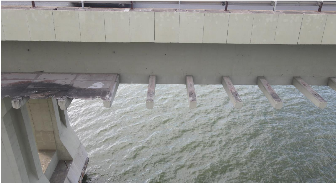
Figura 21 - Transição do trecho com placas do passeio para trecho contendo apenas as vigas
