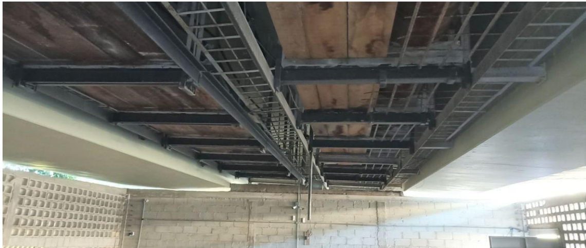
Figura 32 - Vista inferior da passarela de serviços a partir da cabeceira continental
