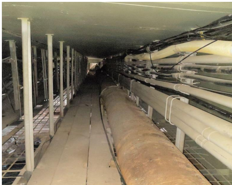
Figura 30 - Passarela de serviço: tábuas de madeira permitem a passagem de pessoas, apenas na lateral sul
