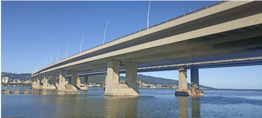
Figura 9 - Passarela norte Colombo Machado Salles
