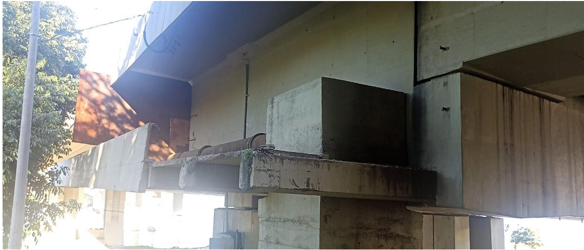
Figura 14 - Entrada da adutora na ponte Colombo Salles, lado norte, cabeceira continental
