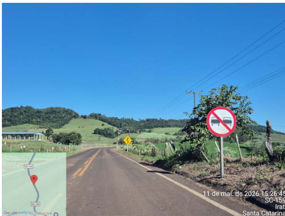
Foto 9 – Conservação e manutenção rodoviária SC 159 – Maio/2026.
