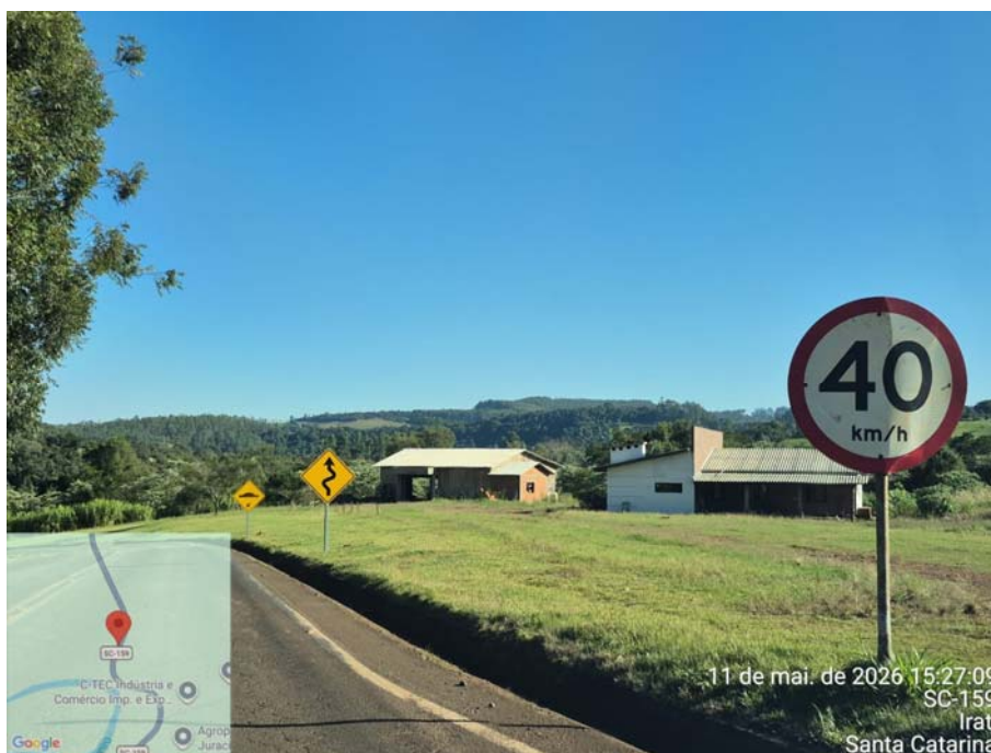
Foto 8 – Conservação e manutenção rodoviária SC 159 – Maio/2026.
