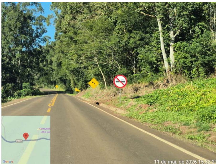
Foto 7 – Conservação e manutenção rodoviária SC 159 – Maio/2026.
