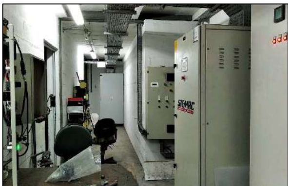
Fotos 21 e 22 – Os painéis de comando instalados no ambiente ao lado do sistema moto gerador apresentam falta de componentes.
