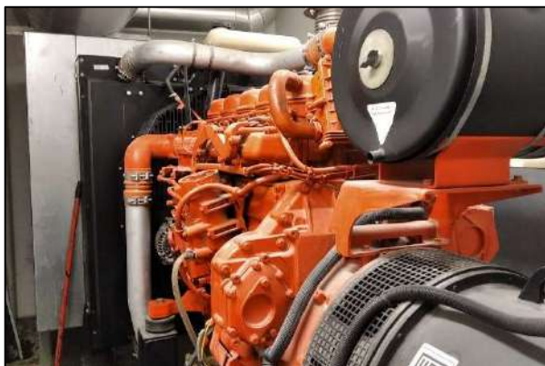
Fotos 19 e 20 – Vistoria interna - Conjunto moto gerador instalado no pavimento Térreo.
