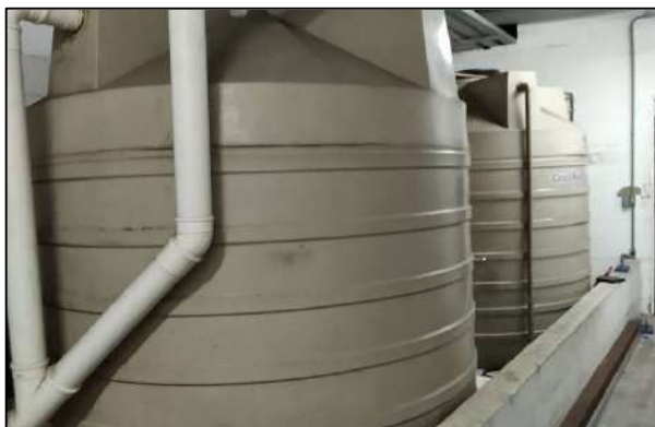
Fotos 17 e 18 – Vistoria pavimento Térreo – Cx. D'água e Cisterna de reaproveitamento de águas pluviais.
