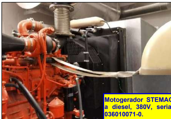
Fotos 19 e 20 – Vistoria interna - Conjunto moto gerador instalado no pavimento Térreo.
