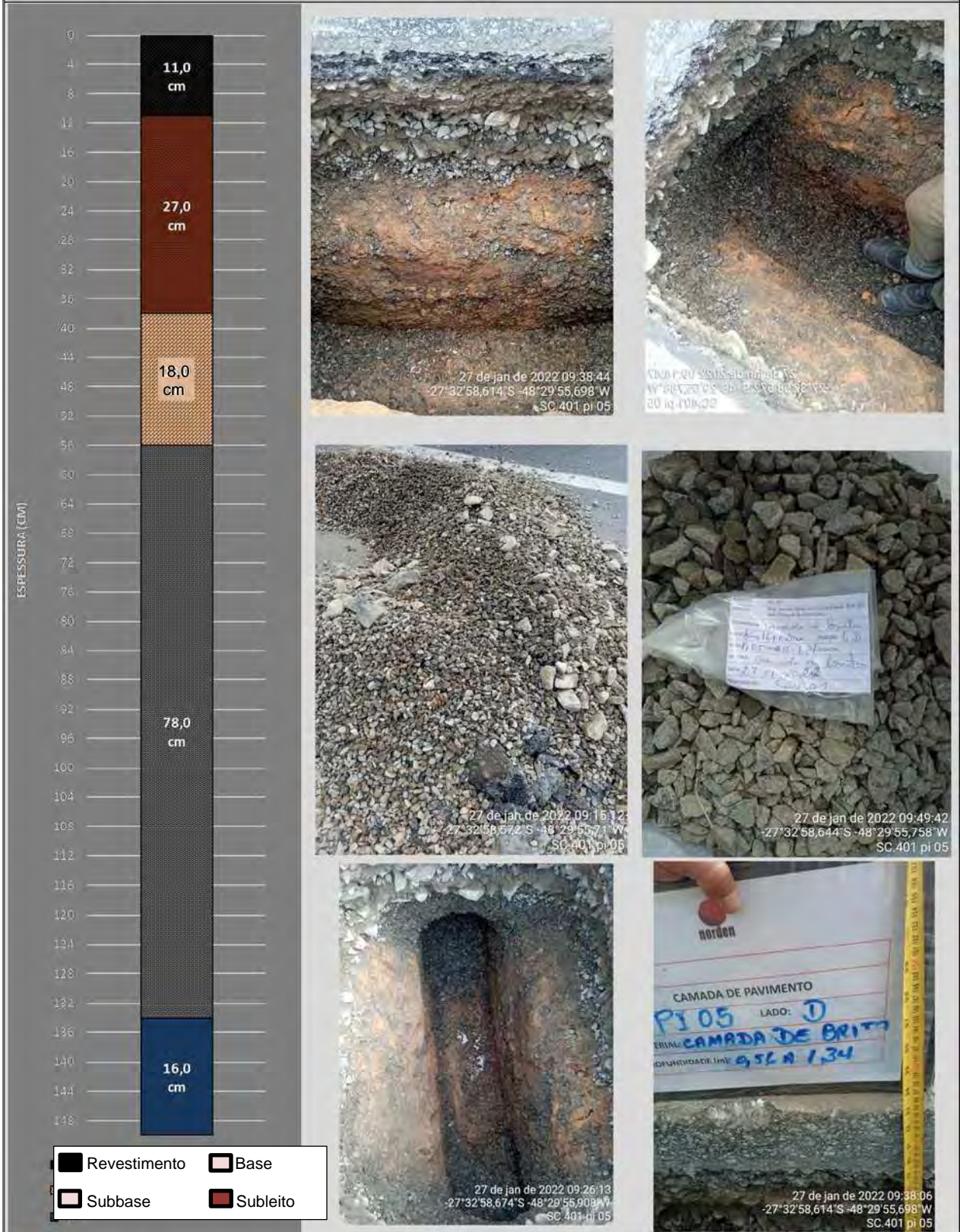
Relatório Fotográfico das amostras dos poços de Inspeção (5)
