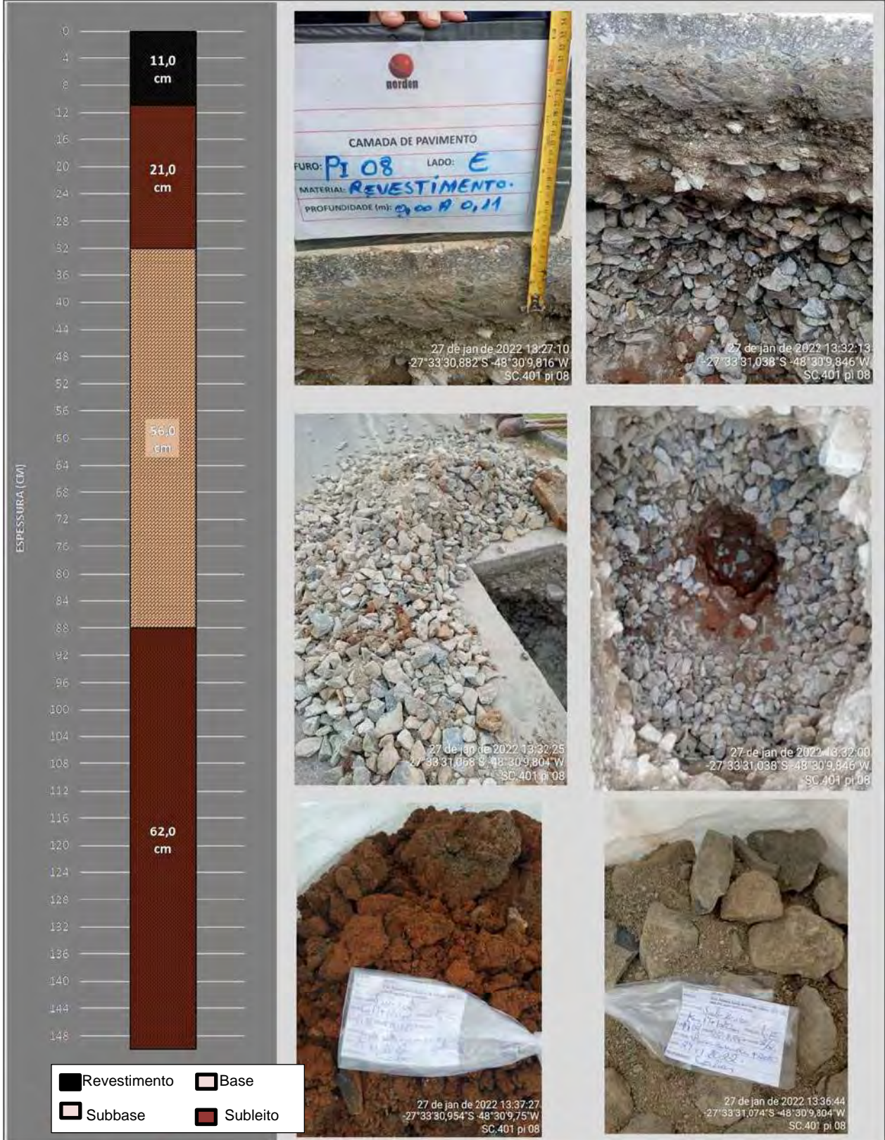
Relatório Fotográfico das amostras dos poços de Inspeção (8)
