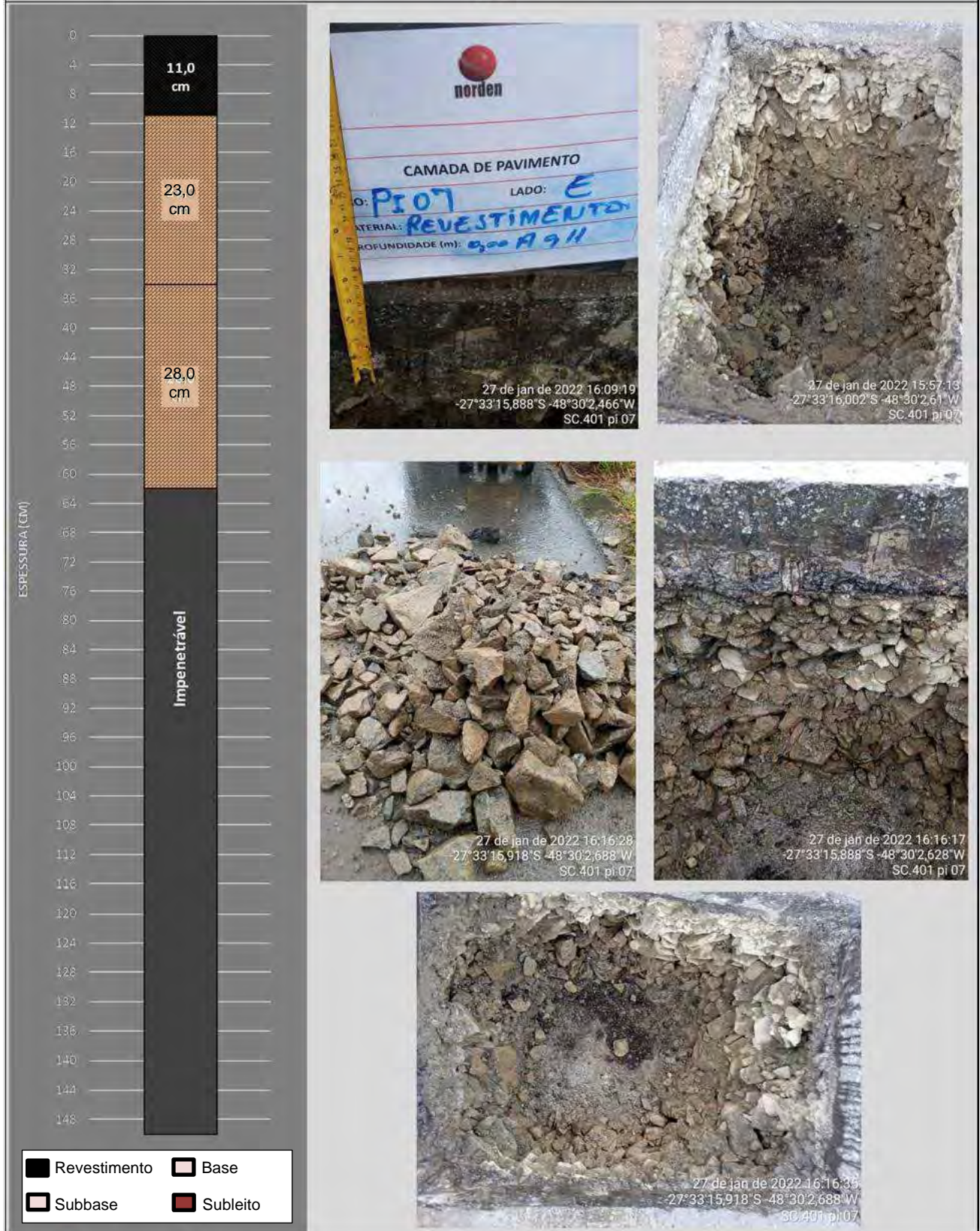
Relatório Fotográfico das amostras dos poços de Inspeção (7)
