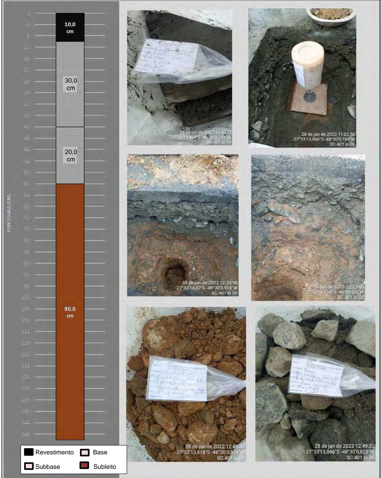
Relatório Fotográfico das amostras dos poços de Inspeção (6)
