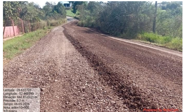
FT 04 – Manutenção da SC 479 – ABR/2026
