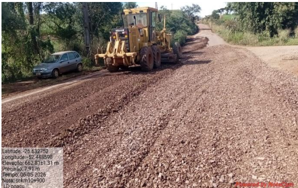
FT 03 – Manutenção da SC 479 – ABR/2026
