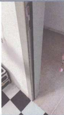
MANUTENÇÃO DA SALA E EQUIPAMENTOS - 20/07/2024
