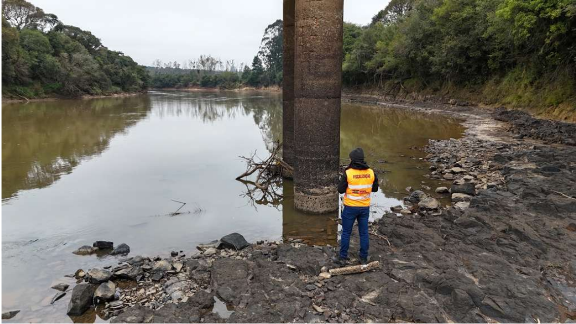
Imagem 27 - Inspeção nos pilares do apoio 4.
