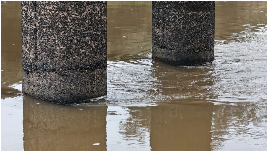
Imagem 38 - Detalhes pilares do apoio 3.
