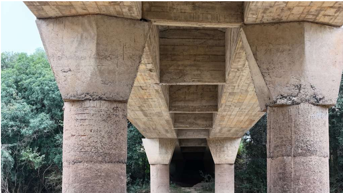
Imagem 16 - Vista Geral apoios.
