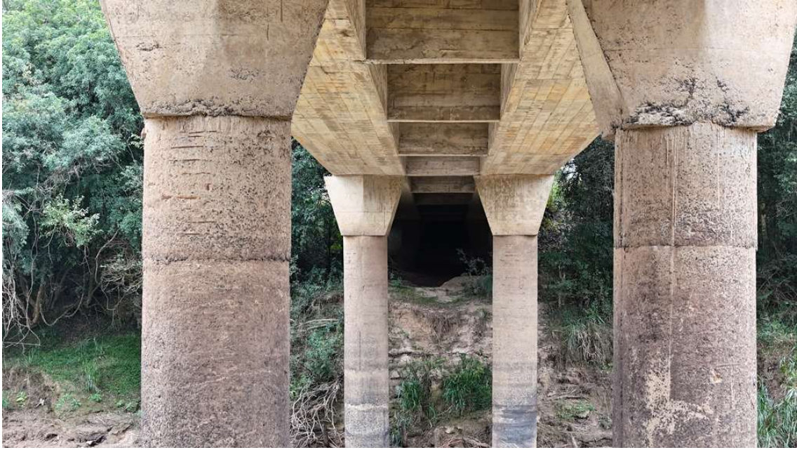
Imagem 15 - Vista Geral apoios.
