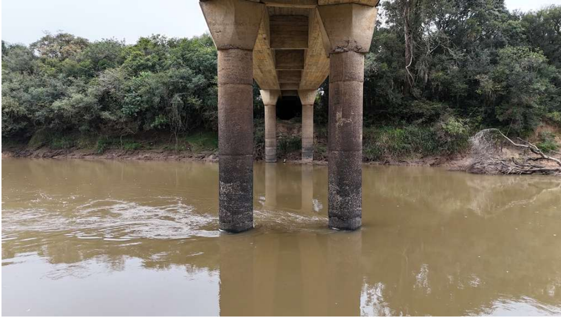
Imagem 43 - Vista geral de pilares.
