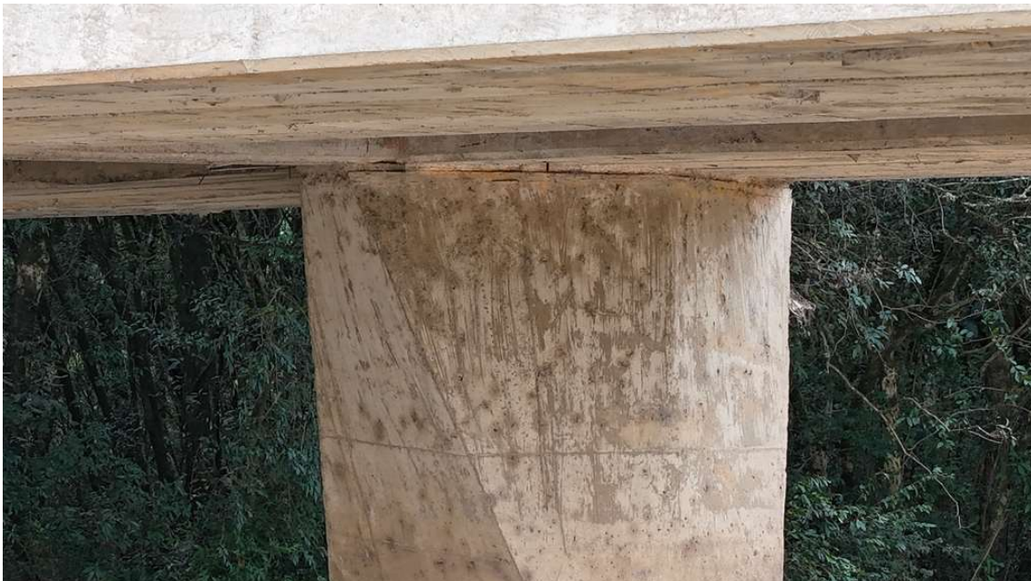
Imagem 18 - Vista detalhe apoio.
