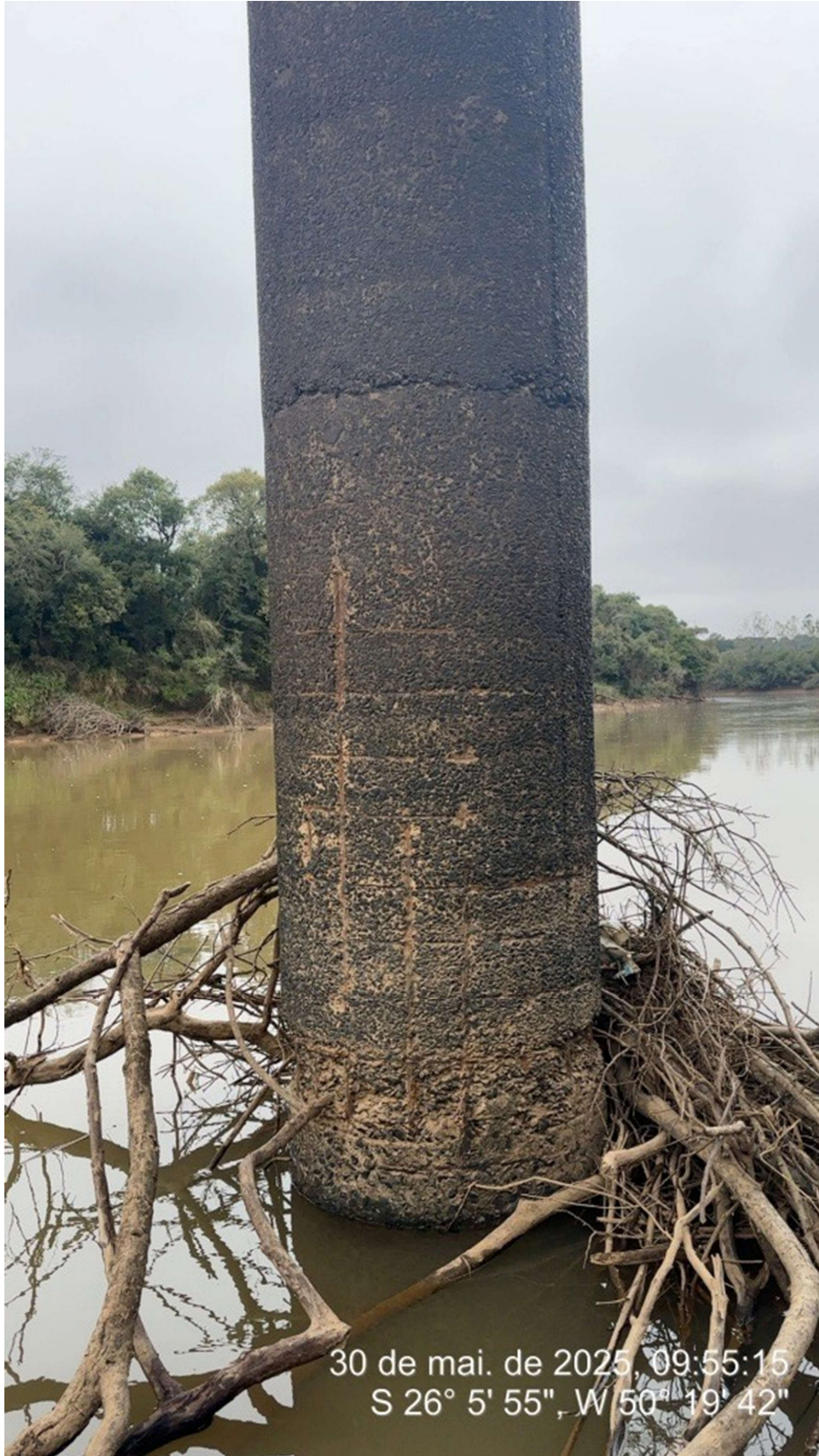
Imagem 41 - Vista geral de pilar.
