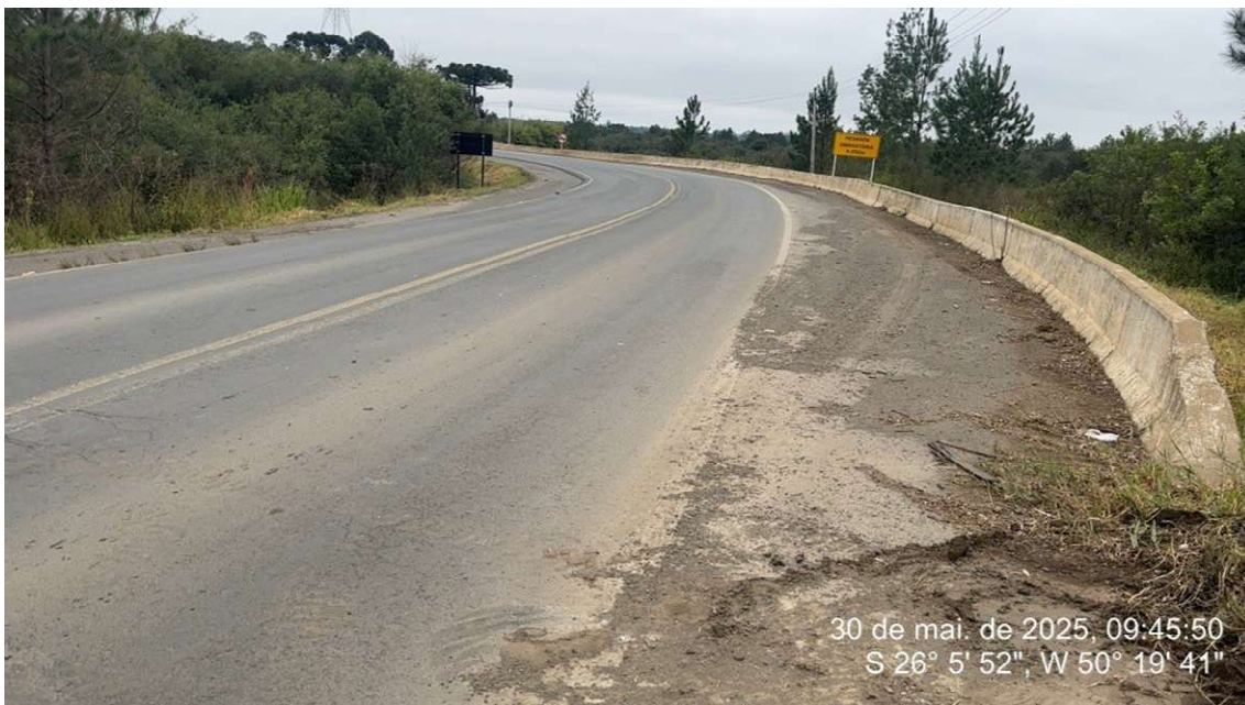
Imagem 3 - Curva de entrada na ponte, município de São Mateus do Sul.
