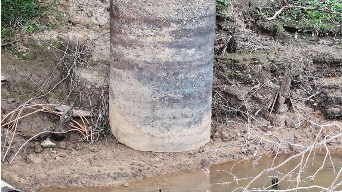
Imagem 39 - Detalhe do pilar em apoio 2.
