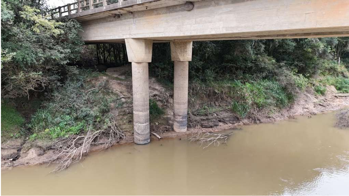
Imagem 13 - Vista geral Apoio 2.
