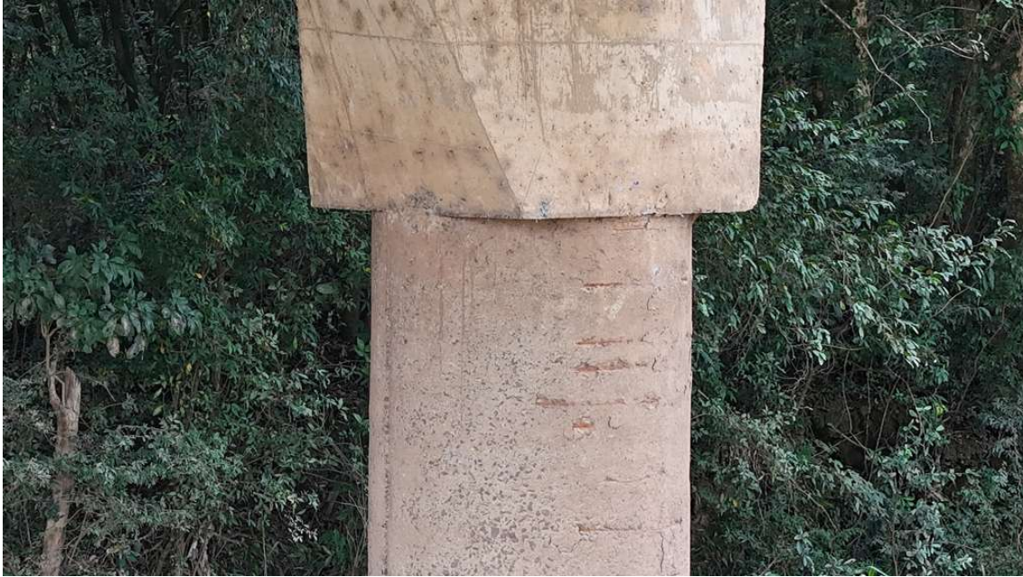
Imagem 17 - Vista detalhe apoio.
