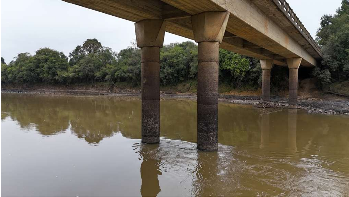
Imagem 45 - vista dos pilares do apoio 3 e apoio 4.
