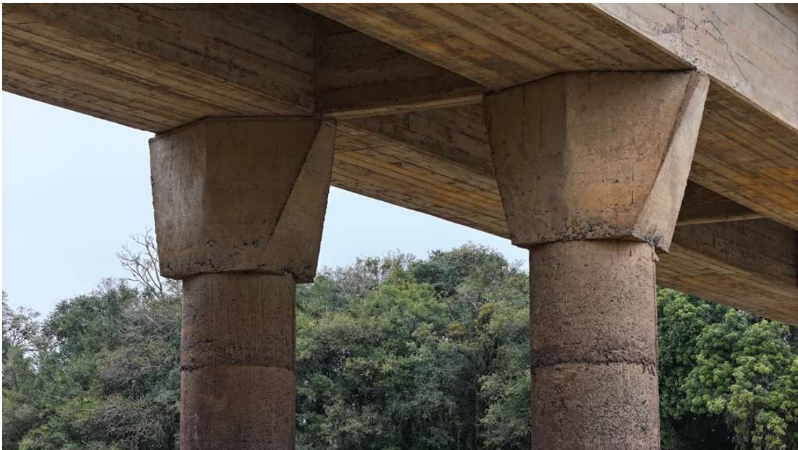
Imagem 14 - Vista Geral apoios.
