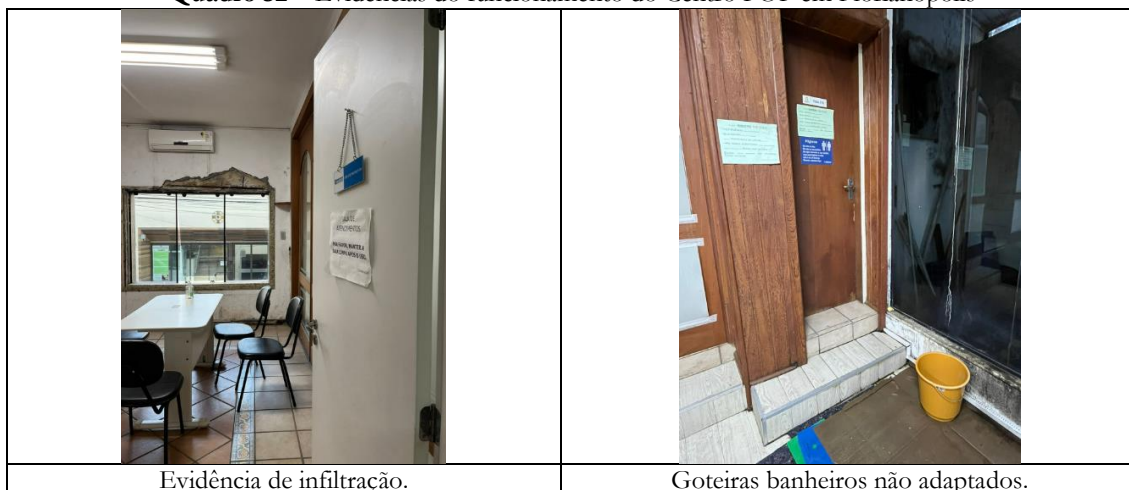
Quadro 32 – Evidências do funcionamento do Centro POP em Florianópolis
