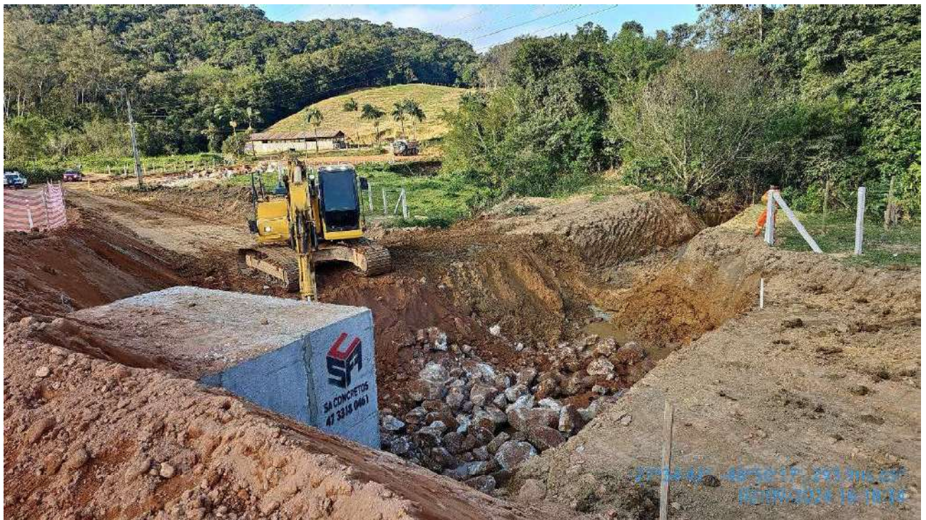
Foto 2 – Execução de BSCC 3,00 x 3,00 – 26+325
