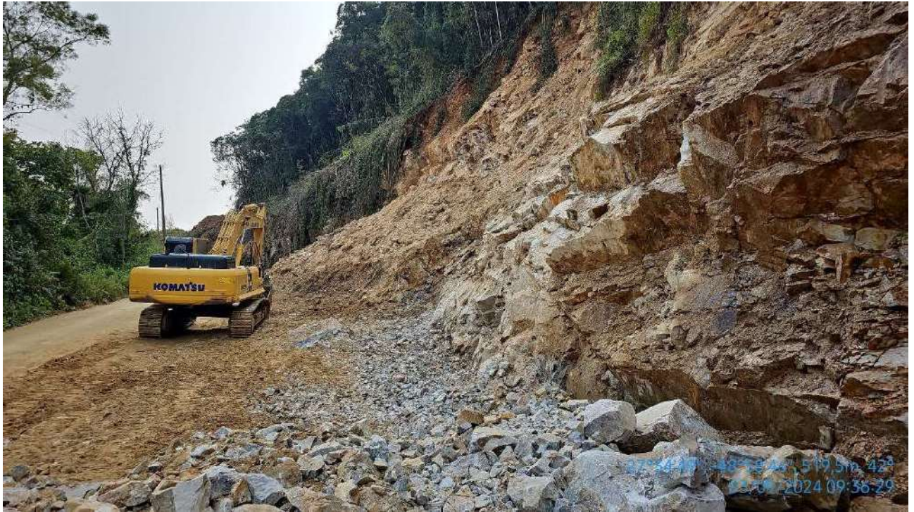
Foto 3 – Escavação de Material de 3ª Cat. km 44+900
