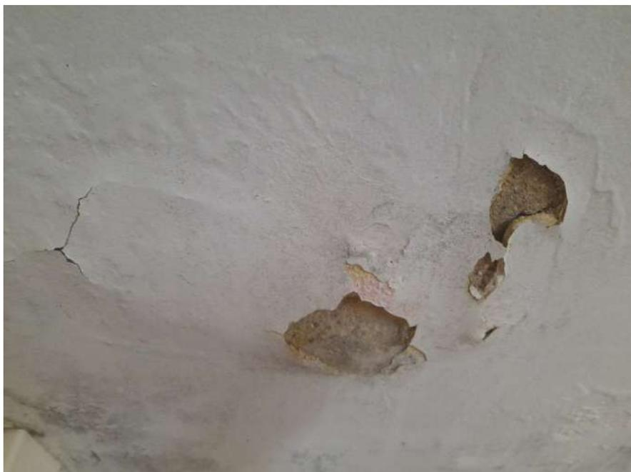
Imagem 06 - Infiltração nas paredes
