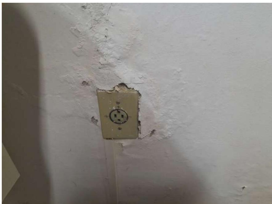
Imagem 07 - Infiltração nas paredes
