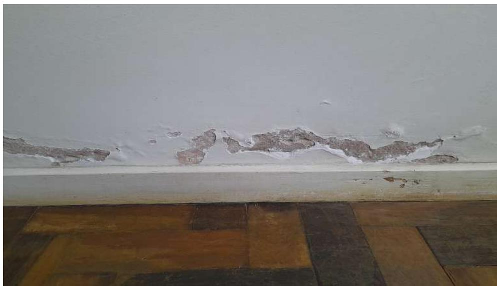
Imagem 05 - Infiltração nas paredes
