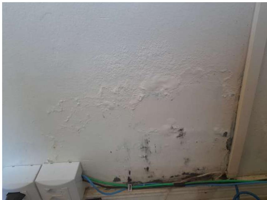
Imagem 08 - Infiltração nas paredes
