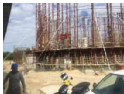
Armaduras ETE Rio Tavares
