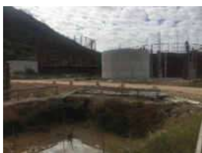
Construção da ETE Rio Tavares
