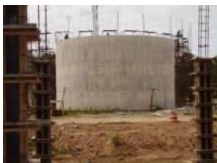
Construção da ETE Rio Tavares
