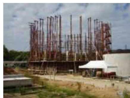
Armaduras ETE Rio Tavares
