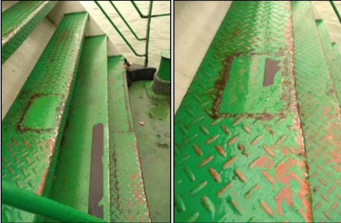
Figura 49: Escadas com degraus com partes faltando material antiderrapante.
