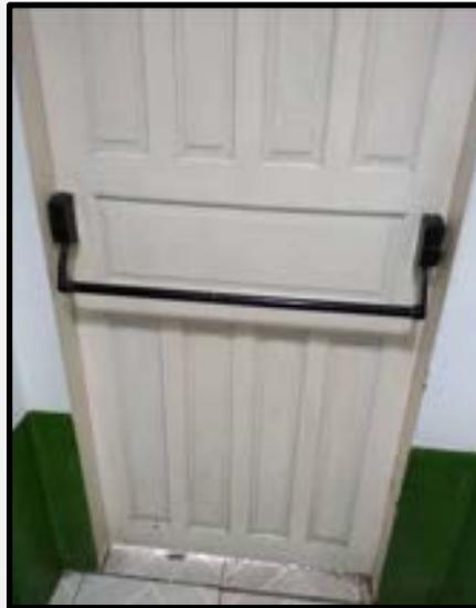
Figura 35: Alavanca porta de emergência com defeito.
