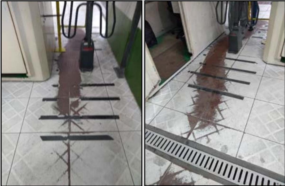
**Figura 54:** Acesso ao embarque em Navegantes - partes faltando material antiderrapante.
