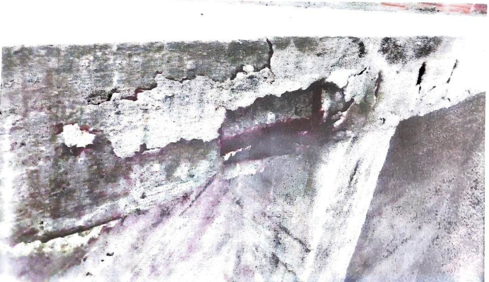
Rachaduras nas vigas que ficam abaixo do refeitório
