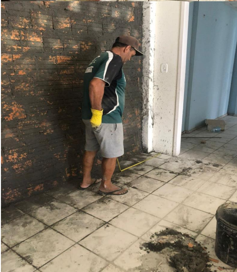
Reforma nova sede-
