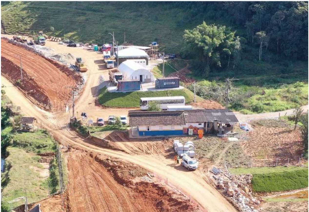
Foto 2 – Canteiro de Obras
