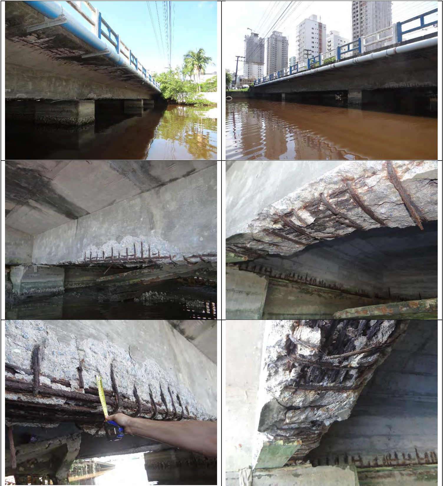
Figura 4 - Face sudoeste: I e II. Vista lateral da ponte / III, IV, V e VI. Viga entre blocos 4 e 5
