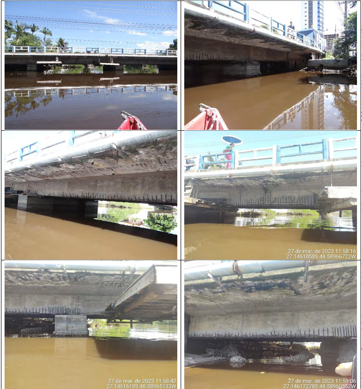
Figura 1 - Vista lateral da ponte, face nordeste
