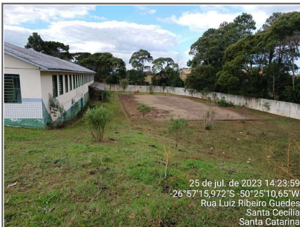
Imagem 3 – Vista da quadra lateral.
