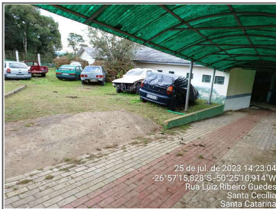
Imagem 4 – Vista oblíqua do pátio da escola sendo utilizada como depósito de veículos.
