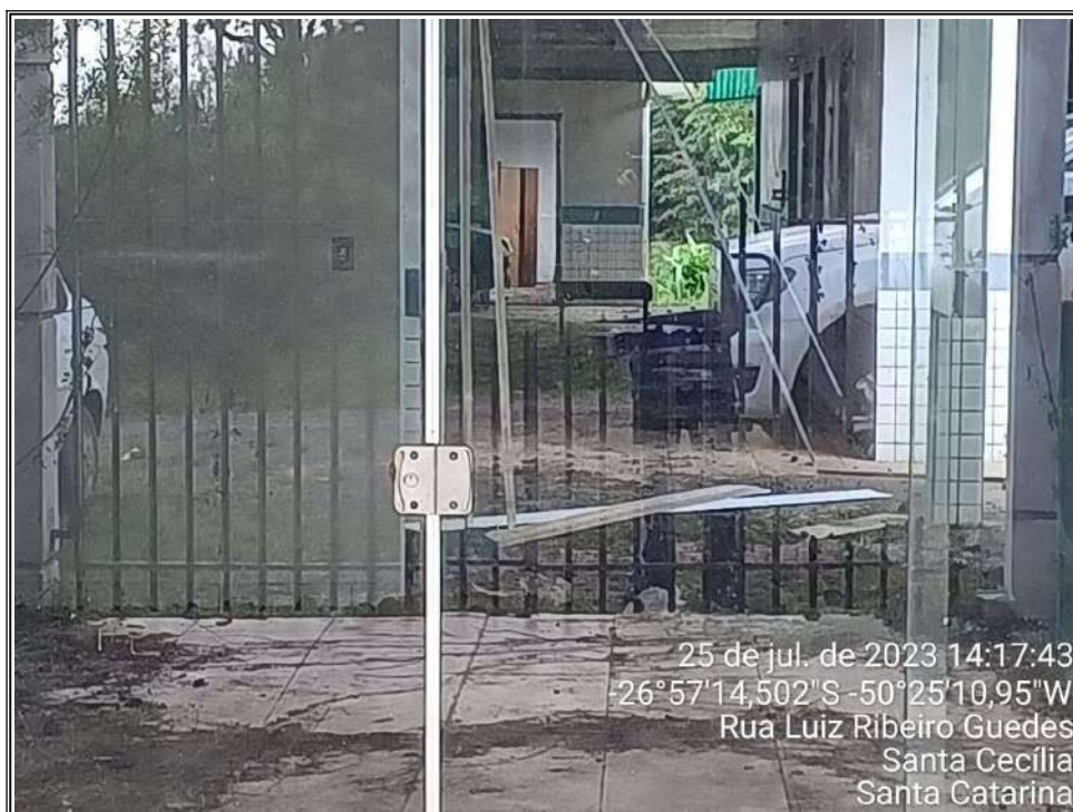
Imagem 7 – Vista aproximada da parte interna (edificação em estado de abandono).
