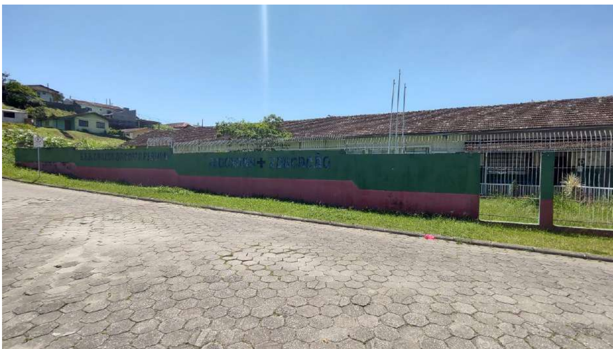
Foto 2 – Vista externa frontal da edificação
